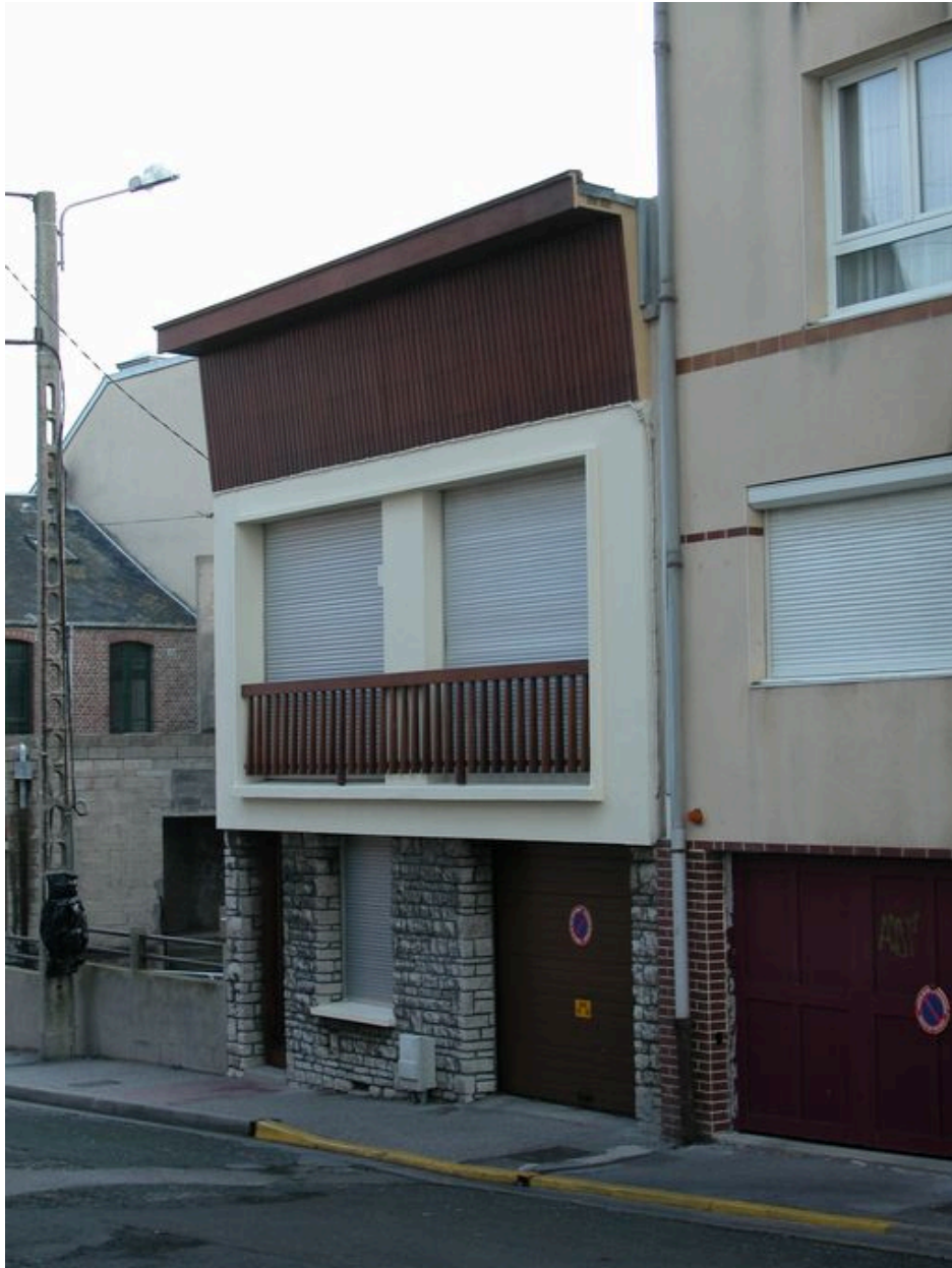
Maison, rue Maurice-Dupont (1982 AE 686).
