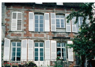
Elévation postérieure, vue partielle. Phot. Martine Plouvier IVR22_19856001315ZA
