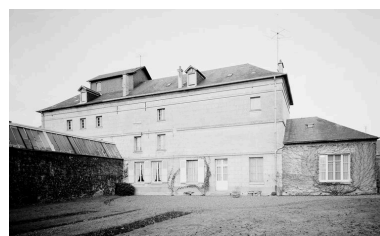
Élévation postérieure. Phot. Fabrice Charrondière IVR22_19856001565V
