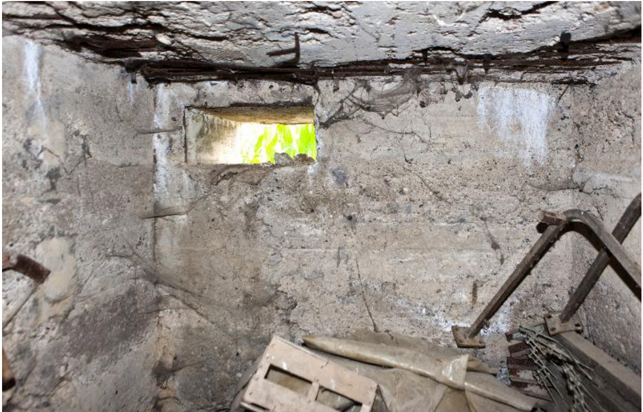
Vue intérieure, vers l'est
