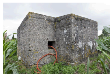
Vue de trois-quarts vers le nord-est Phot. Jean-Marc Ramette IVR31_20145905478NUCA
