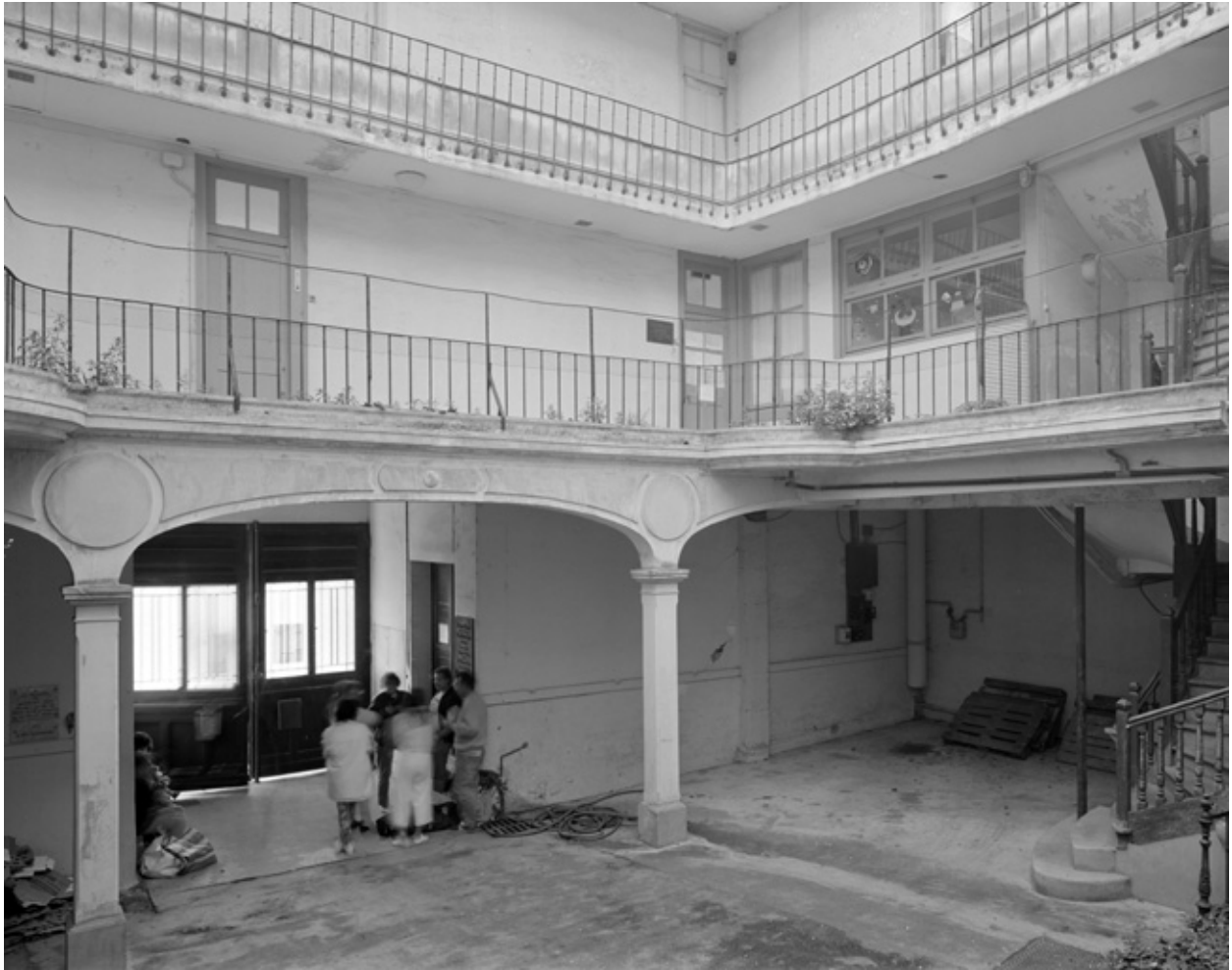
Elévation sur la cour.
