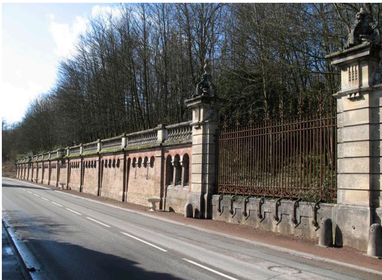
Mur de clôture.
