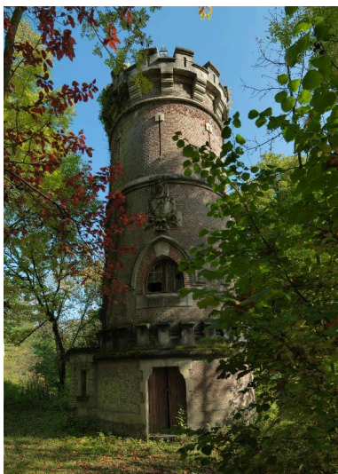
Le château d'eau. Phot. Thierry Lefébure IVR22_20128001044NUC2A
