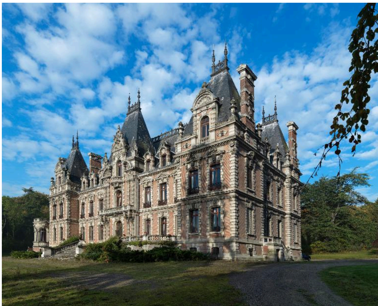
Vue d'ensemble sud-est du château.
