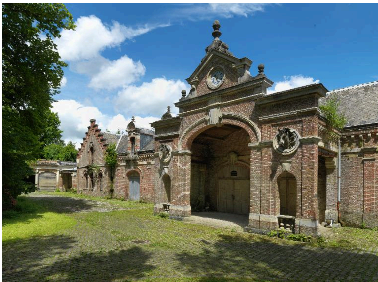
Les communs, vue extérieure des écuries.
