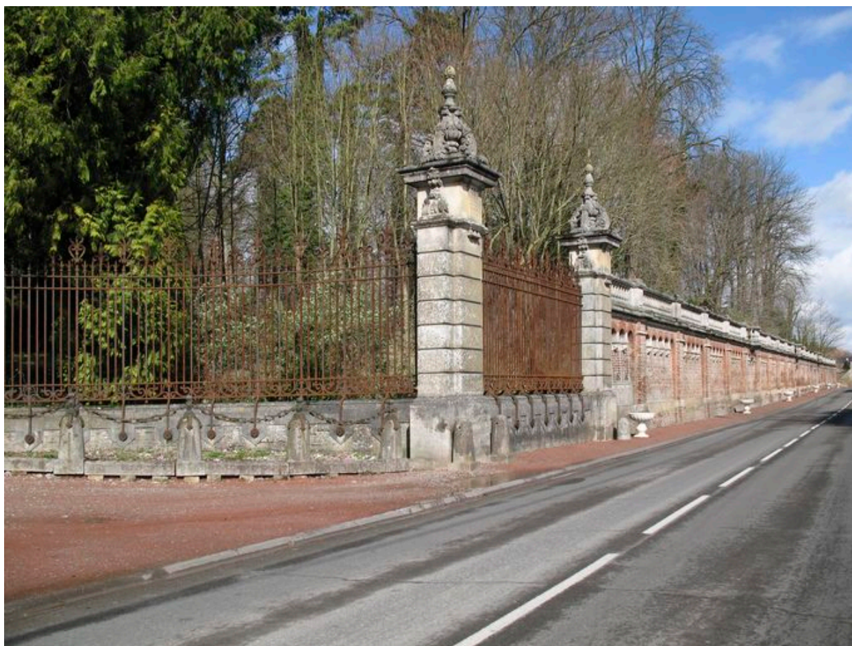
Mur de clôture.
