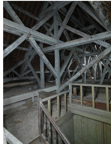
Détail de la partie centrale de la charpente des combles. Phot. Thierry Lefébure IVR22_20128000383NUC2A
