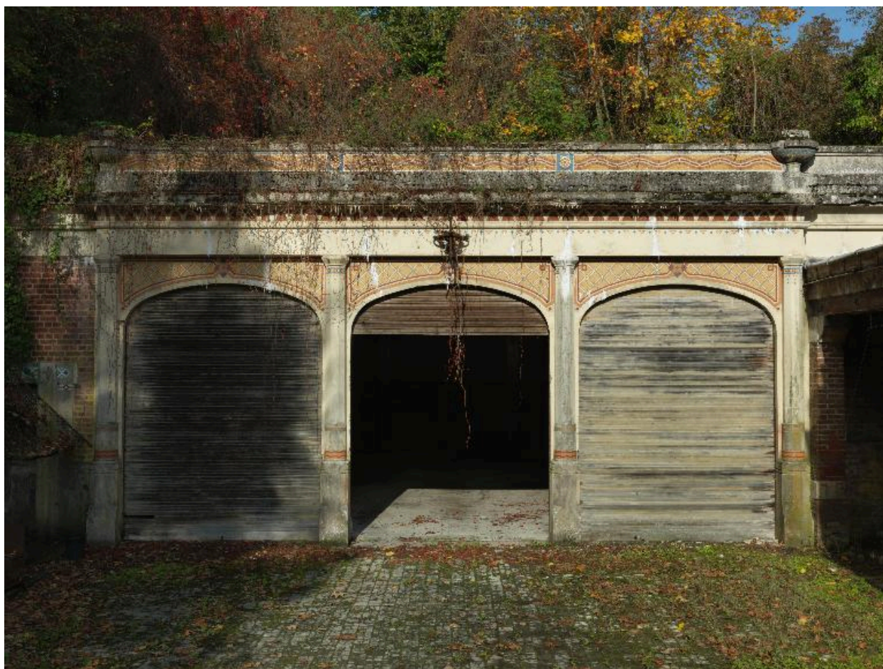
Entrée du garage automobile.
