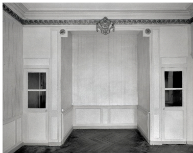
Ancien logis abbatial : vue partielle de l'alcôve de la chambre à coucher du premier étage, encadrée de ses deux cabinets. Phot. Thierry Lefébure IVR22_19920201592V
