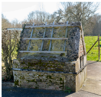
Ancien puits près de la mairie, vue depuis le nord. Phot. Marc Kérignard IVR32_20256000119NUCA
