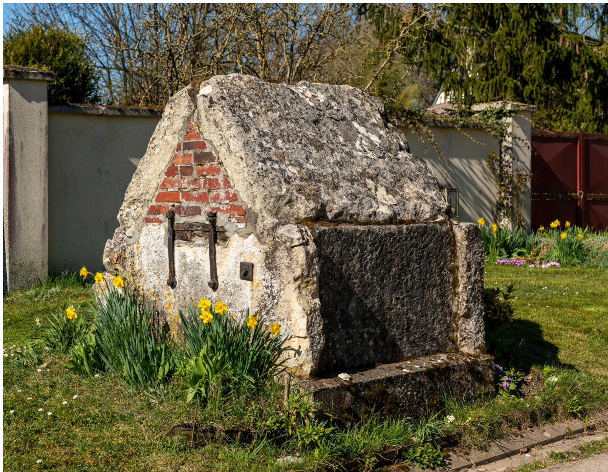
Ancien puits de la rue Lefèvre, vue depuis le sud-est.
