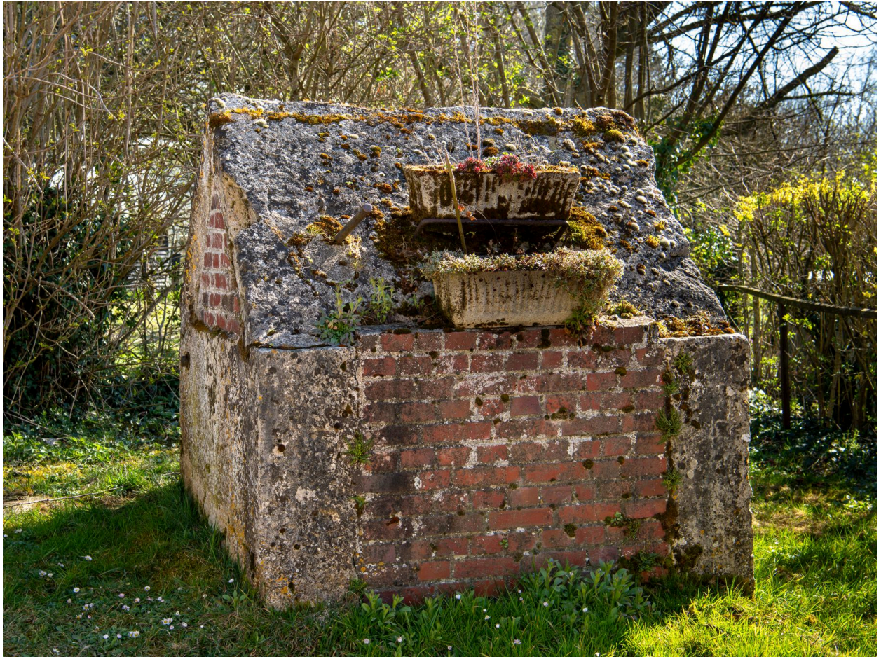
Puits dans la rue Behaize (en face du n°67), vue depuis le nord.
