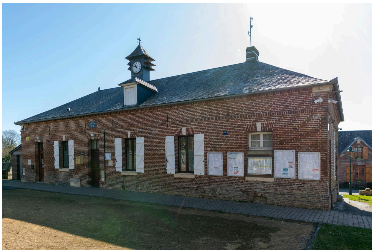
Ancienne mairie-école, aujourd'hui mairie, vue depuis le nord.
