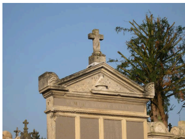
Vue de détail sur le fronton. Phot. Isabelle Barbedor IVR22_20048010806NUCA
