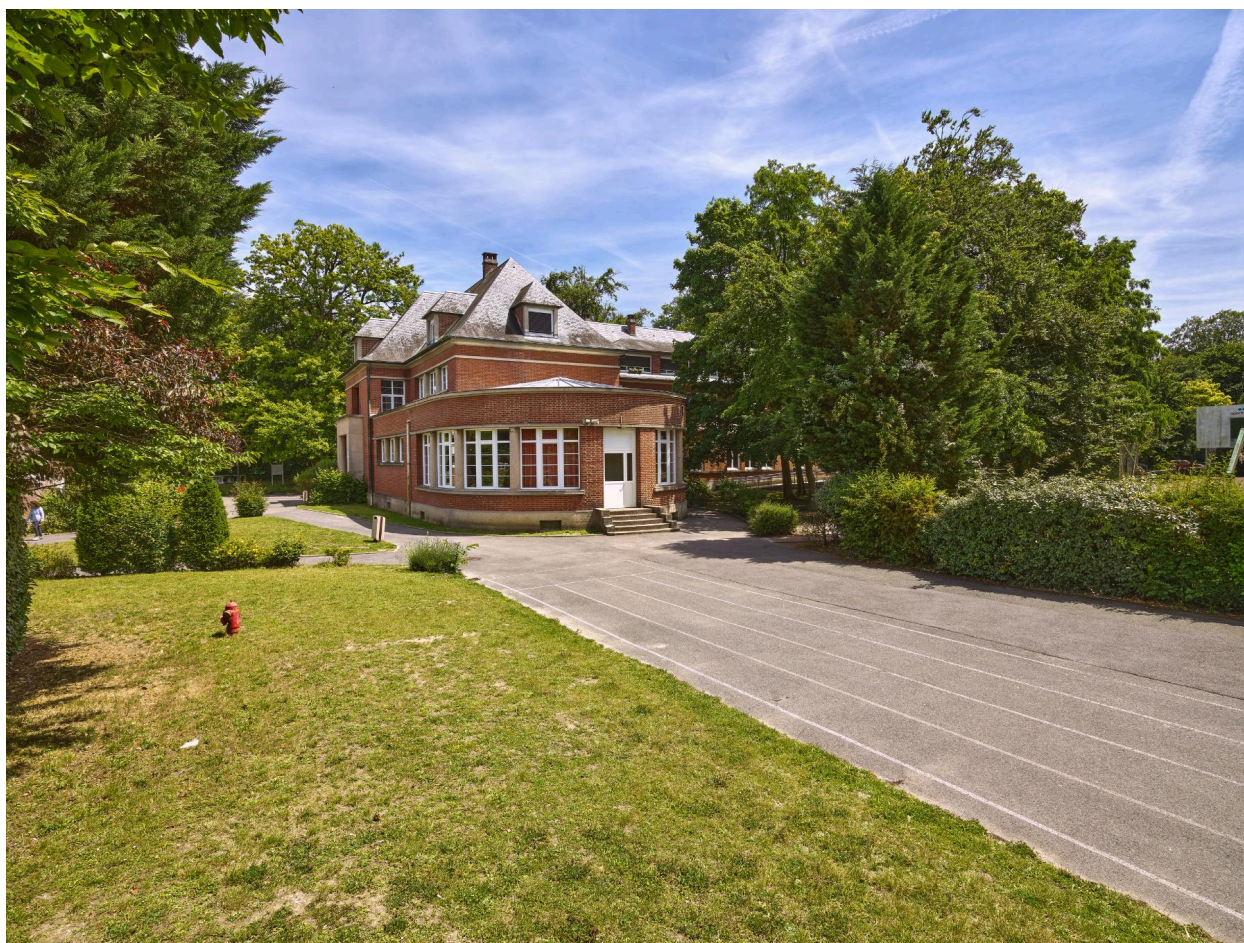
Bâtiment B et pistes d'athlétisme, du lycée Pierre d'Ailly vue du sud-est.
