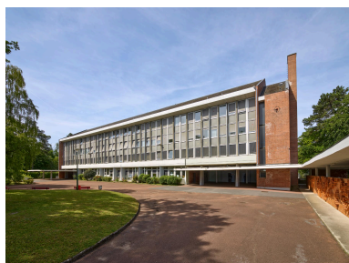
Bâtiment F du lycée Pierre d'Ailly, vue du sud-ouest. Phot. Thierry Lefébure IVR32_20226000626NUCA
