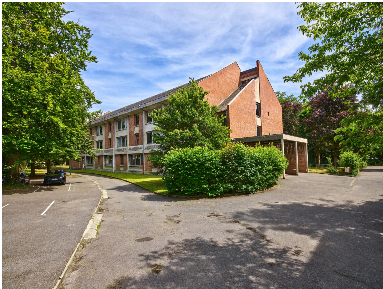
Bâtiment D du lycée Pierre d'Ailly, vue du sud-est.
