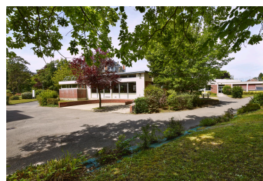
Bâtiment E, service de restauration, du lycée Pierre d'Ailly vue du nord-est. Phot. Thierry Lefébure IVR32_20226000638NUCA
