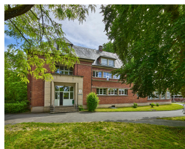
Bâtiment B du lycée Pierre d'Ailly vue du sud. Phot. Thierry Lefébure IVR32_20226000644NUCA
