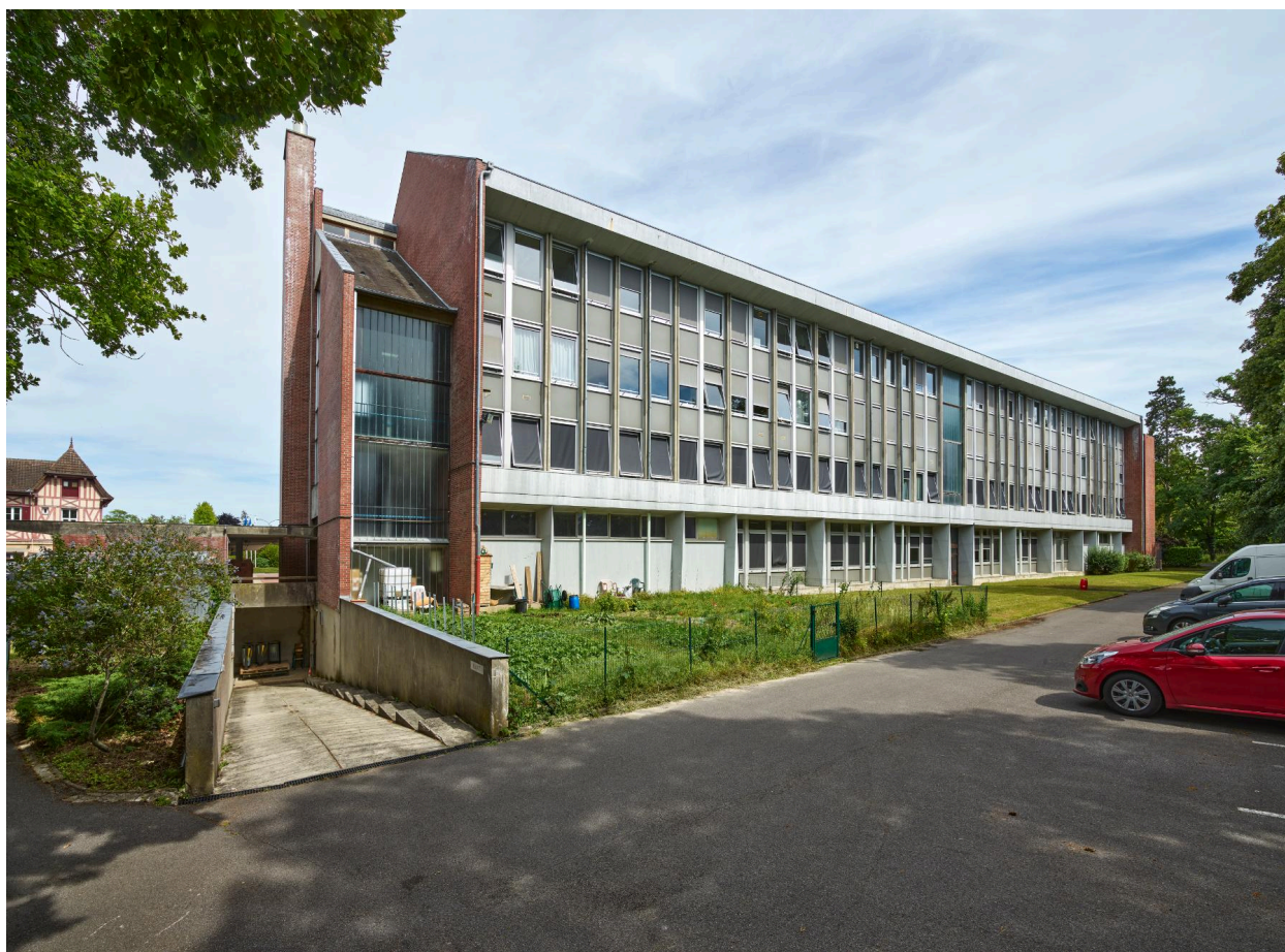
Bâtiment F du lycée Pierre d'Ailly vu de l'est.
