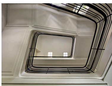
Escalier de l'internat des filles, bâtiment B du lycée Pierre d'Ailly. Phot. Thierry Lefébure IVR32_20226000649NUCA
