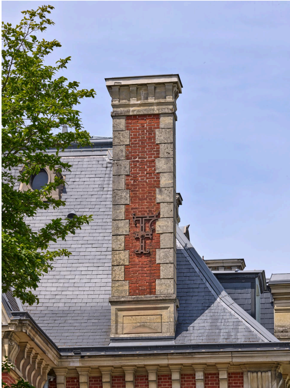
Souche de cheminée de la villa des comtes Foy, avec ancre de tirant en forme de lettre F, actuellement lycée Pierre d'Ailly.
