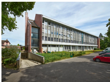
Bâtiment F du lycée Pierre d'Ailly vu de l'est. Phot. Thierry Lefébure IVR32_20226000633NUCA
