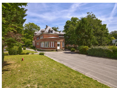
Bâtiment B et pistes d'athlétisme, du lycée Pierre d'Ailly vue du sud-est. Phot. Thierry Lefébure IVR32_20226000639NUCA
