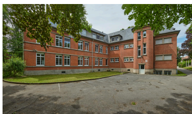
Bâtiment B du lycée Pierre d'Ailly, internat, vue du nord-ouest. Phot. Thierry Lefébure IVR32_20226000653NUCA
