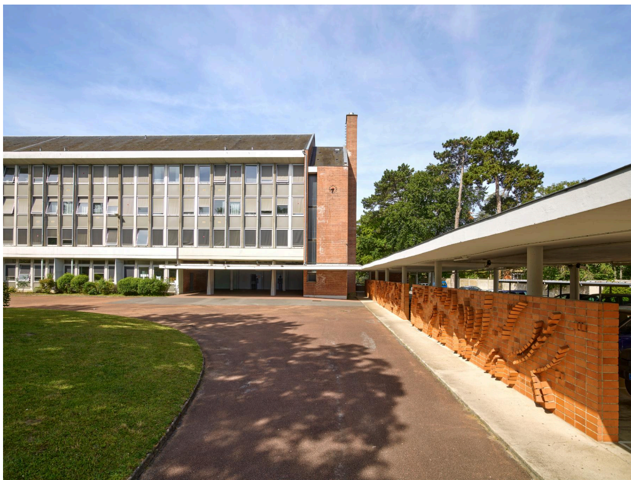
Préau du bâtiment F du lycée Pierre d'Ailly, vue du sud-ouest.
