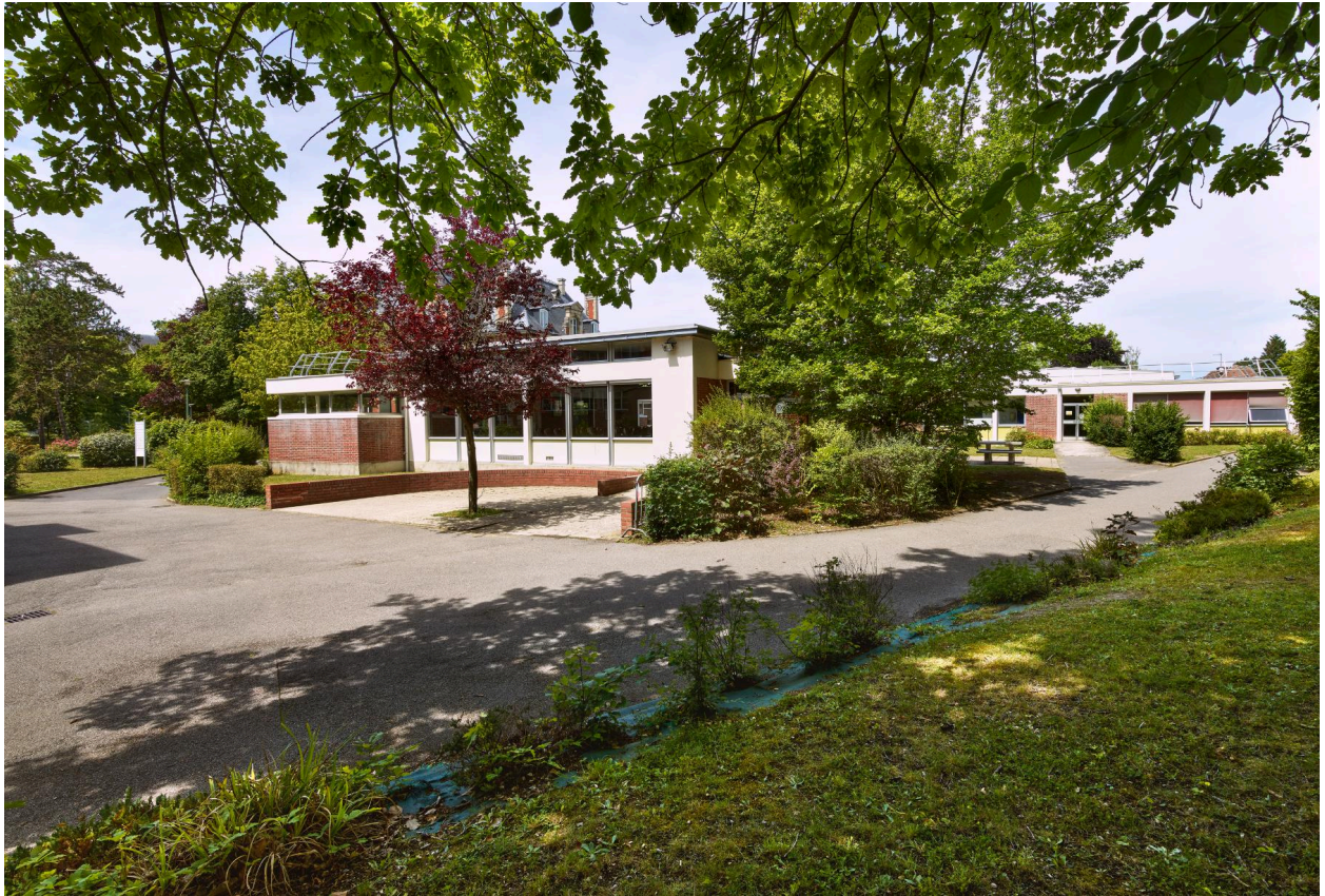
Bâtiment E, service de restauration, du lycée Pierre d'Ailly vue du nord-est.
