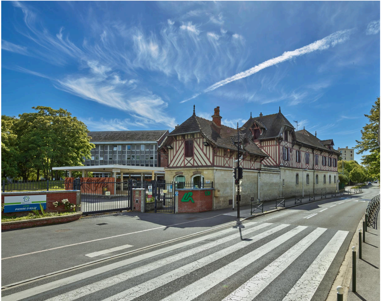
Vue du sud-est des dépendances de la villa des comtes Foy, actuel bâtiment technique, et bâtiment F du lycée Pierre d'Ailly.
