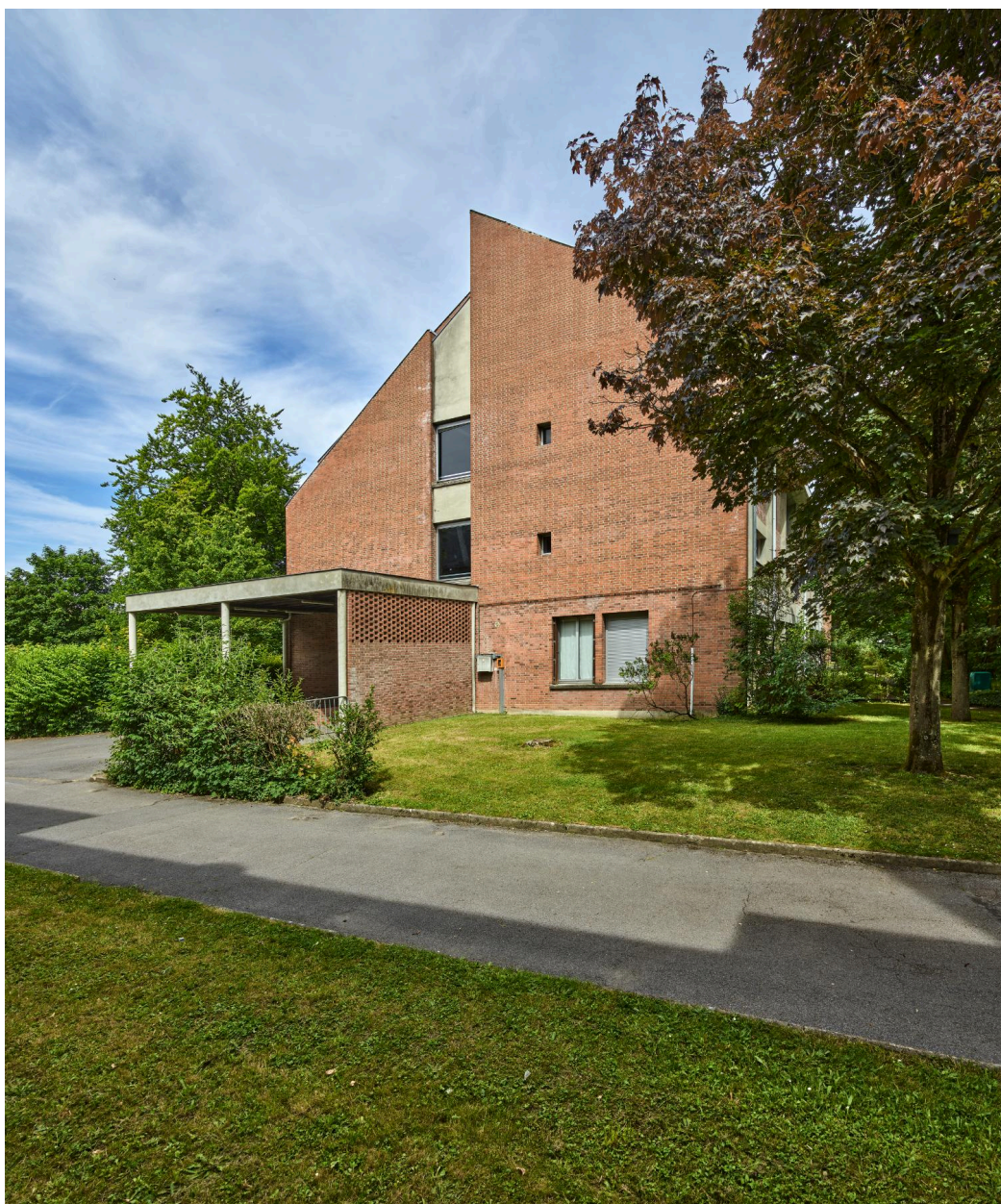
Bâtiment D du lycée Pierre d'Ailly, vue de l'est.
