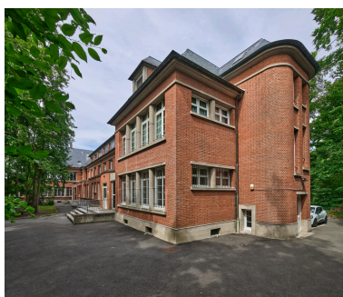
Bâtiment A du lycée Pierre d'Ailly, vue du nord-est. Phot. Thierry Lefébure IVR32_20226000654NUCA
