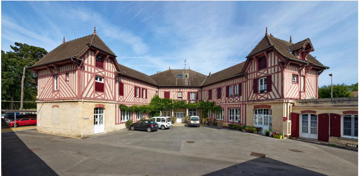
Vue nord-ouest des dépendances de la villa des comtes Foy, actuel bâtiment technique du lycée Pierre d'Ailly.
