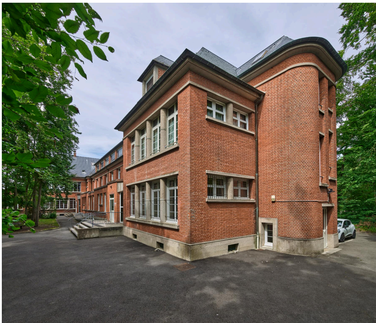
Bâtiment A du lycée Pierre d'Ailly, vue du nord-est.
