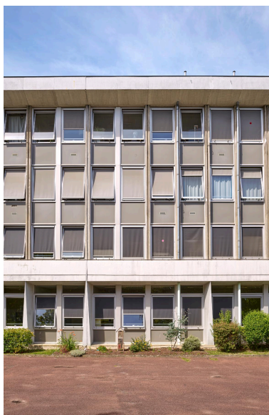
Façade tramée du bâtiment F du lycée Pierre d'Ailly, vue du sud-ouest. Phot. Thierry Lefébure IVR32_20226000628NUCA
