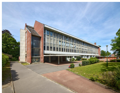
Bâtiment F du lycée Pierre d'Ailly vu de l'est. Phot. Thierry Lefébure IVR32_20226000632NUCA
