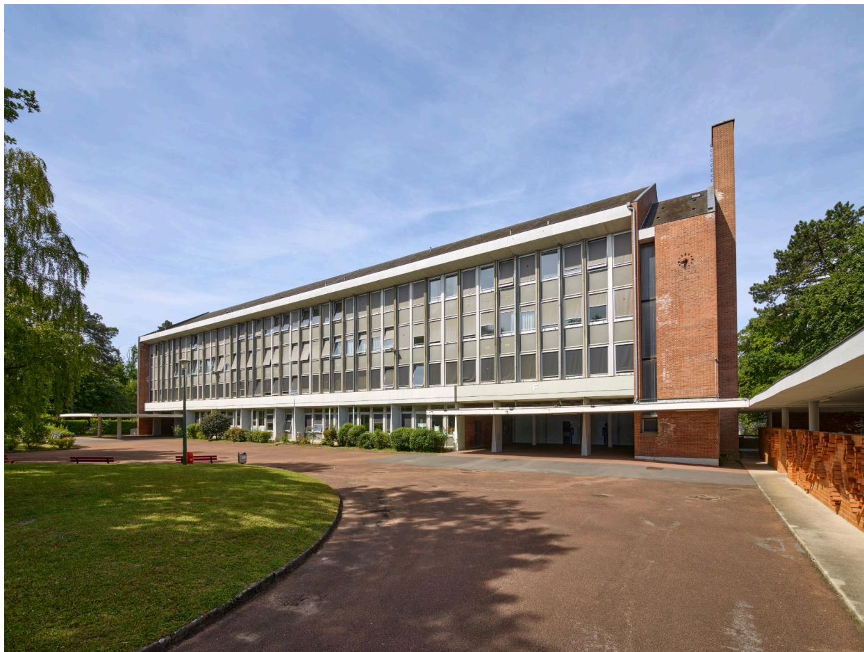
Bâtiment F du lycée Pierre d'Ailly, vue du sud-ouest.
