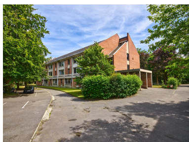
Bâtiment D du lycée Pierre d'Ailly, vue du sud-est. Phot. Thierry Lefébure IVR32_20226000651NUCA
