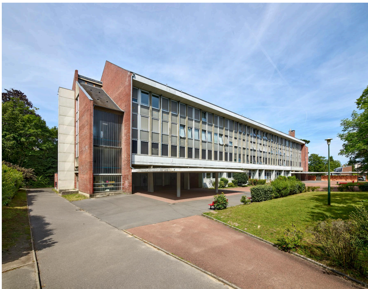
Bâtiment F du lycée Pierre d'Ailly vu de l'est.
