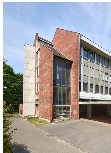
Cage d'escalier nord du bâtiment F du lycée Pierre d'Ailly vu du nord-est. Phot. Thierry Lefébure IVR32_20226000630NUCA
