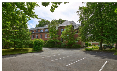
Bâtiment B du lycée Pierre d'Ailly, internat, vue de l'ouest. Phot. Thierry Lefébure IVR32_20226000650NUCA
