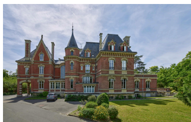
Façade sud de la villa des comtes Foy, actuel lycée Pierre d'Ailly. Phot. Thierry Lefébure IVR32_20226000612NUCA
