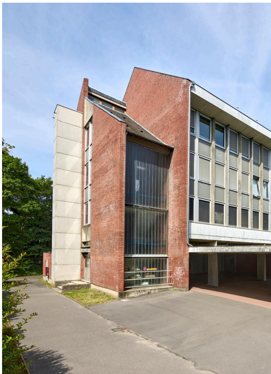
Cage d'escalier nord du bâtiment F du lycée Pierre d'Ailly vu du nord-est.
