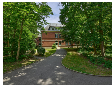
Bâtiment C du lycée Pierre d'Ailly vue de l'ouest. Phot. Thierry Lefébure IVR32_20226000642NUCA
