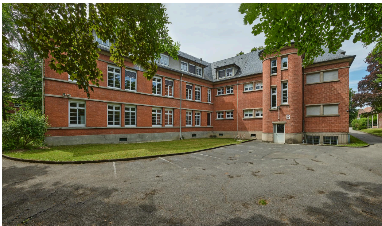
Bâtiment B du lycée Pierre d'Ailly, internat, vue du nord-ouest.
