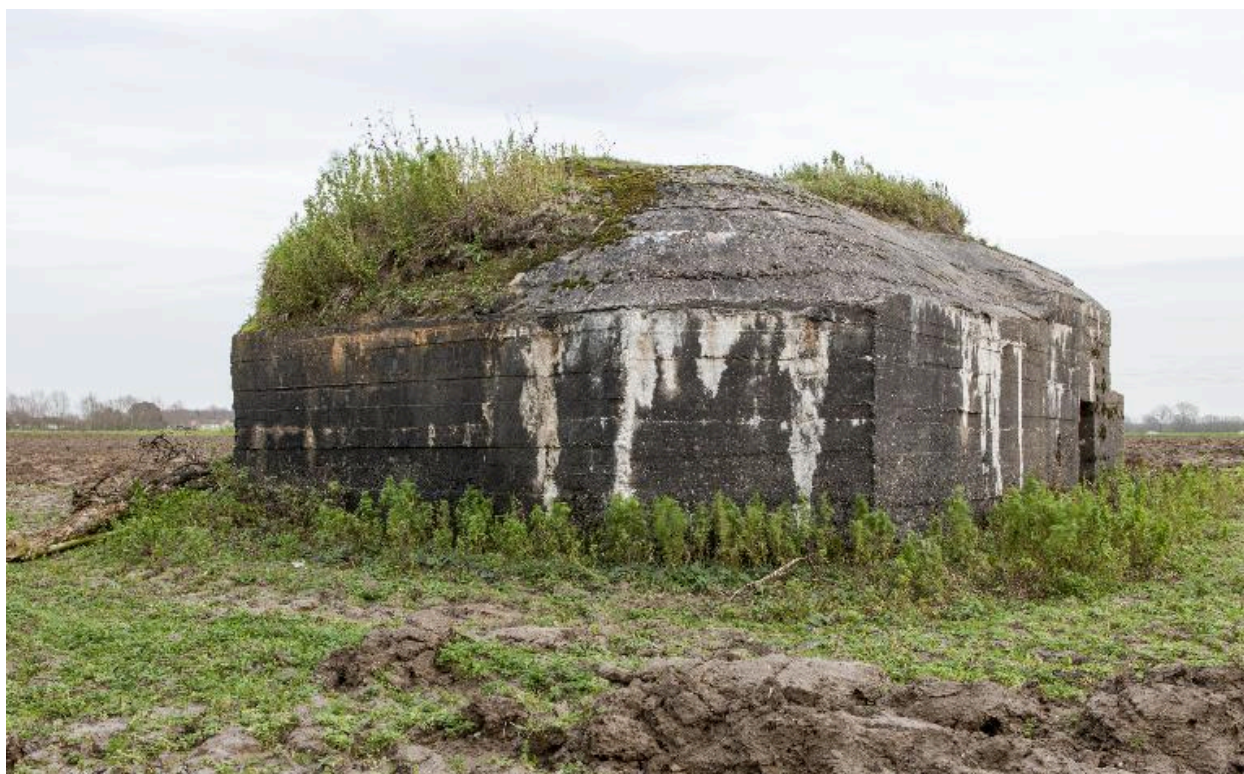
Vue de trois-quarts arrière, vers le nord-est
