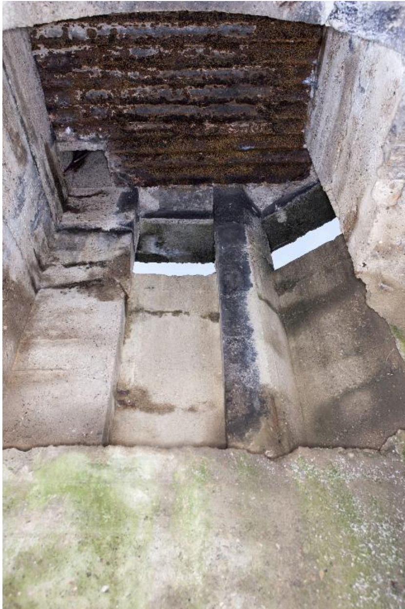
Le poste d'observation, en contre-plongée
