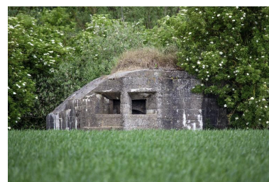
Embrasures sur l'élévation est Phot. Jean-Marc Ramette IVR32_20165901163NUCA
