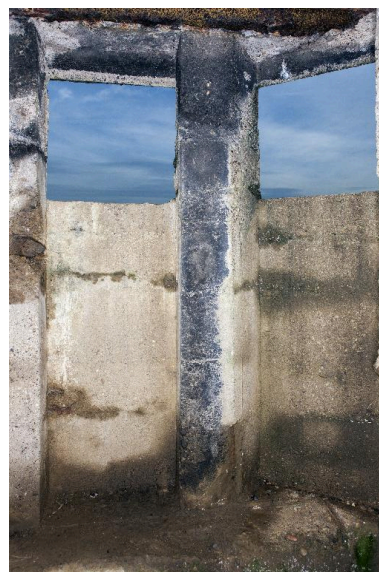
Depuis le couloir, le poste d'observation Phot. Pierre Thibaut IVR31_20155902055NUCA
