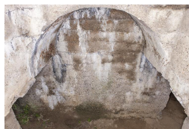
Depuis le poste d'observation, voûte perpendiculaire au couloir de distribution Phot. Pierre Thibaut IVR31_20155902056NUCA
