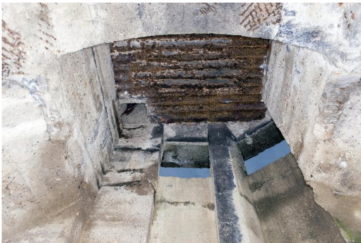
Le poste d'observation, en contre-plongée
