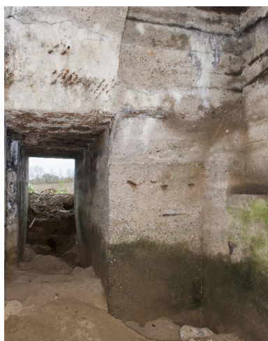
Couloir de distribution en enfilade Phot. Pierre Thibaut IVR31_20155902052NUCA
