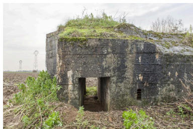
Entrée nord et couloir de distribution en enfilade Phot. Pierre Thibaut IVR31_20155902058NUCA
