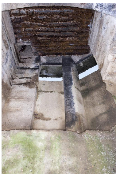
Le poste d'observation, en contre-plongée Phot. Pierre Thibaut IVR31_20155902054NUCA
