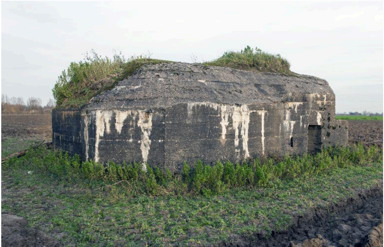
Vue de trois-quarts arrière, vers le nord-est
