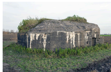
Vue de trois-quarts arrière, vers le nord-est Phot. Pierre Thibaut IVR31_20155902044NUCA
