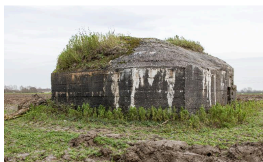
Vue de trois-quarts arrière, vers le nord-est Phot. Pierre Thibaut IVR31_20155902060NUCA
