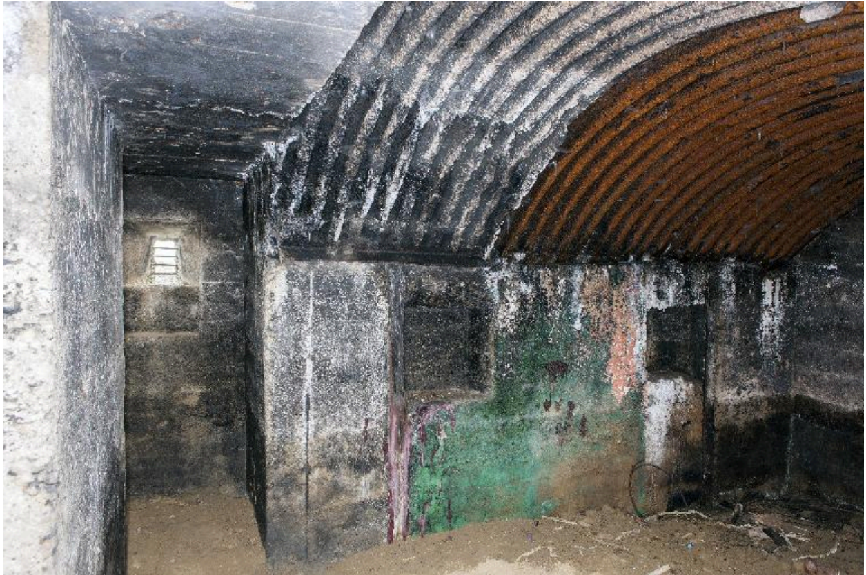
Créneau de fusillade sud et salle principale
