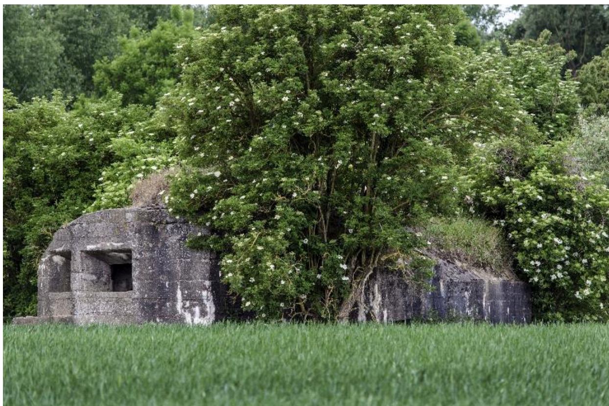
Vue générale vers le sud-ouest
