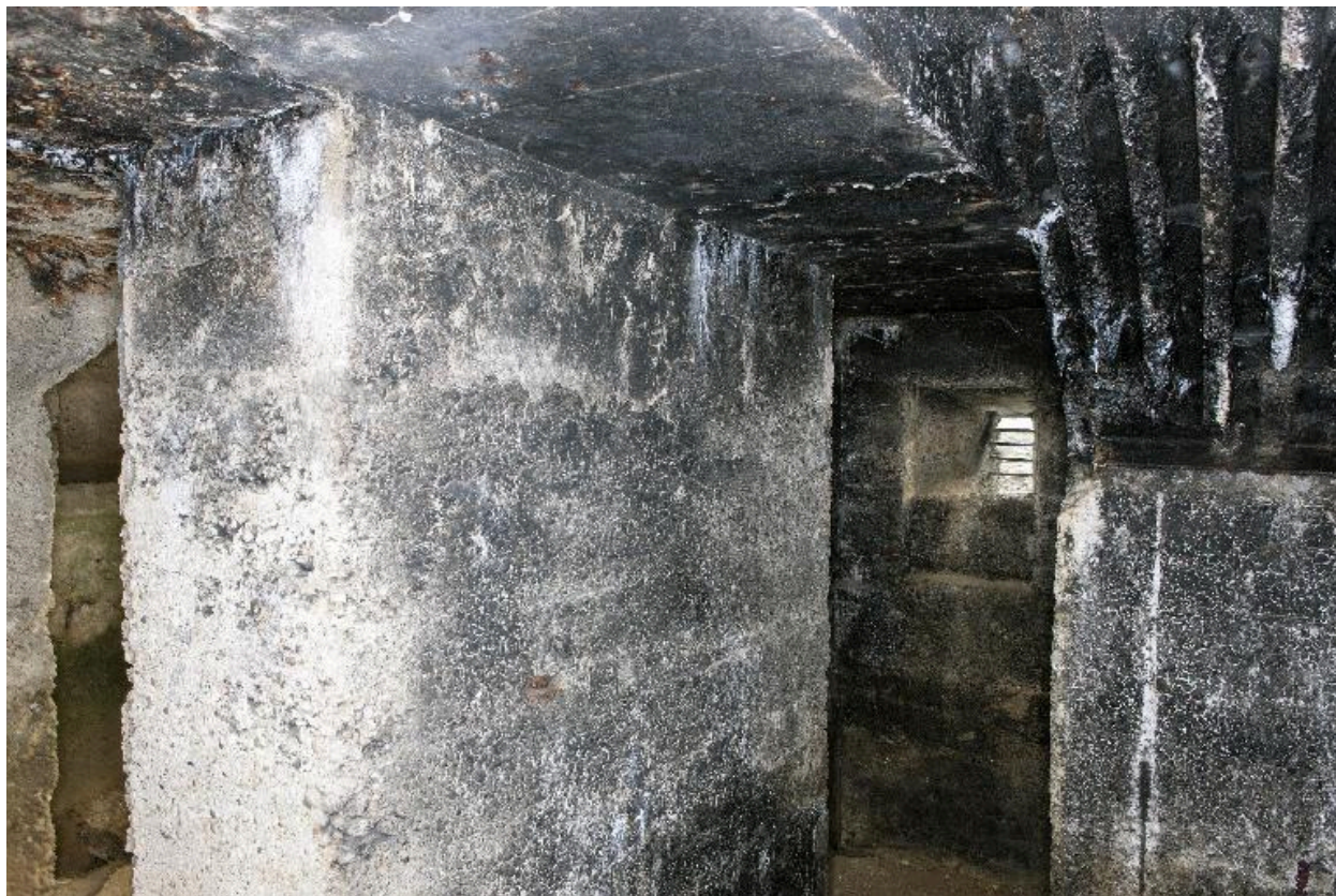
Créneau de fusillade nord, depuis le couloir
