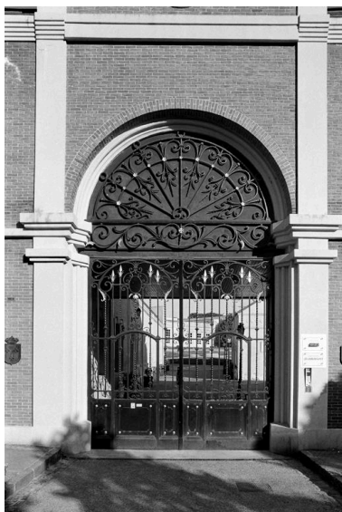
Vue de la grille du portail de l'entrée de l'usine, depuis la place de l'hôtel-Dieu (après la transformations de 1989). Phot. Pierre-Yves Brest IVR22_19990202120Z
