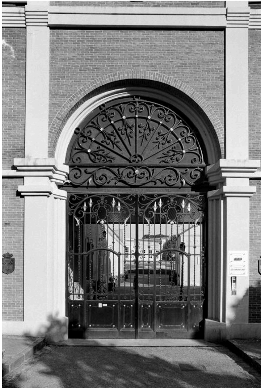
Vue de la grille du portail de l'entrée de l'usine, depuis la place de l'hôtel-Dieu (après la transformations de 1989).
