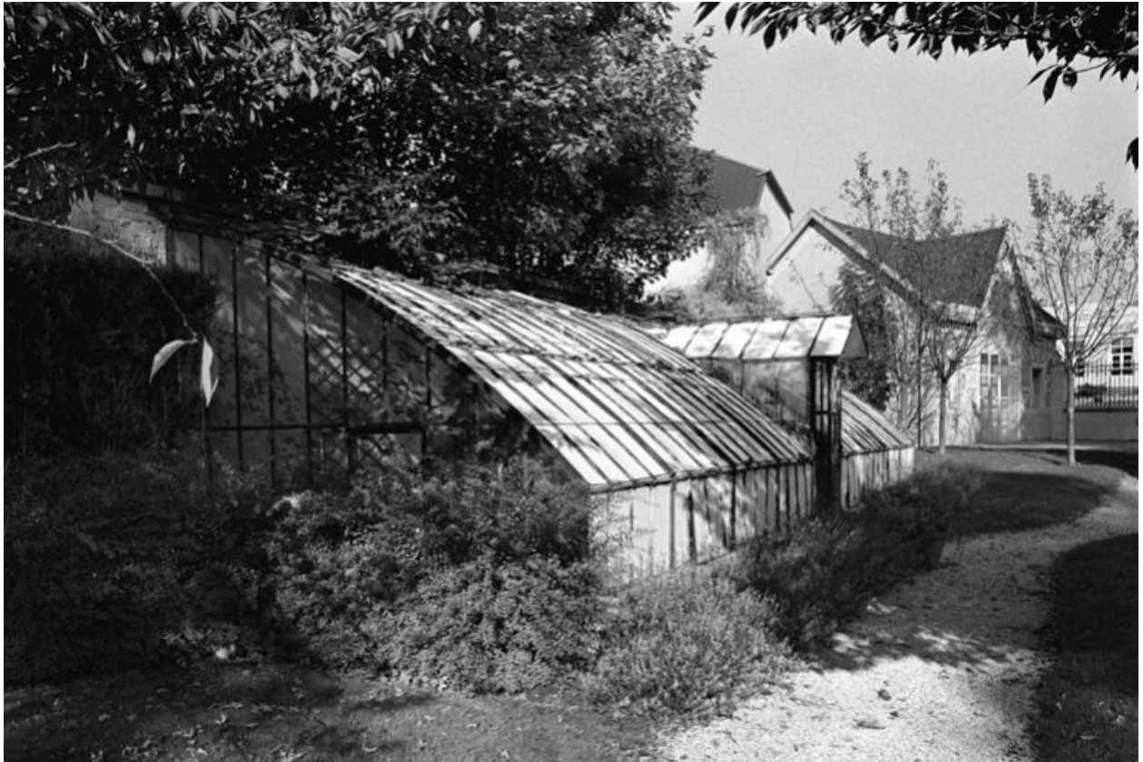
Vue d'ensemble de la serre.
