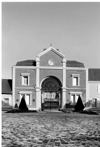
Vue de l'entrée de l'usine, depuis la place de l'hôtel-Dieu (après la transformations de 1989). Phot. Pierre-Yves Brest IVR22_19990202119Z
