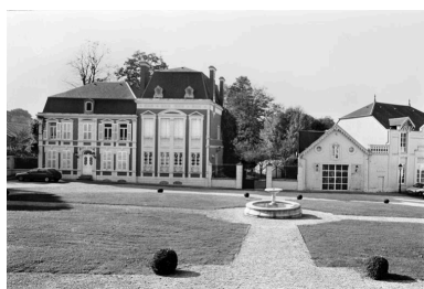
Vue de l'ancienne cour transformée en jardin en 1989, avec la maison patronale à gauche et l'ancienne remise à droite. Phot. Pierre-Yves Brest IVR22_19990206216Z
