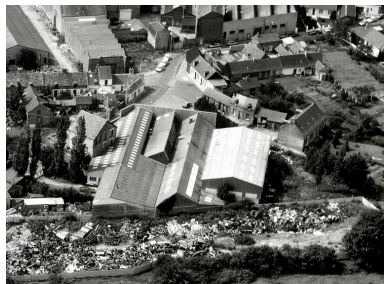
Vue aérienne de la fonderie Couillet-Legay en 1988. Phot. Phot'R IVR22_19888001655P
