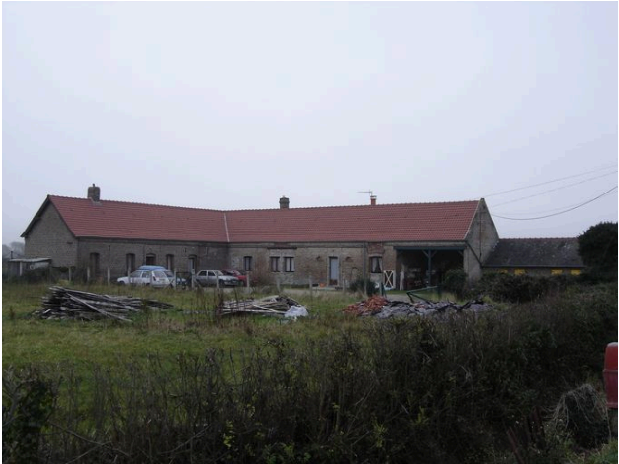
Vue générale depuis l'est.
