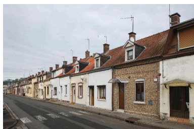
Vue d'ensemble de la cité ouvrière Saint-Gaston. Phot. Thierry Lefébure IVR22_20138000521NUC2A
