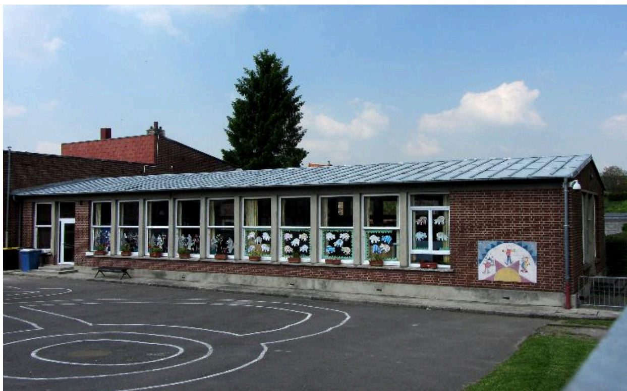
Façade sur cour de la salle de la classe.
