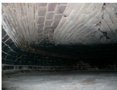
Vue intérieure du four à pain. Phot. Inès Guérin IVR22_20078005900NUCA
