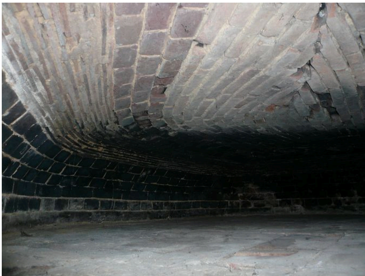
Vue intérieure du four à pain.
