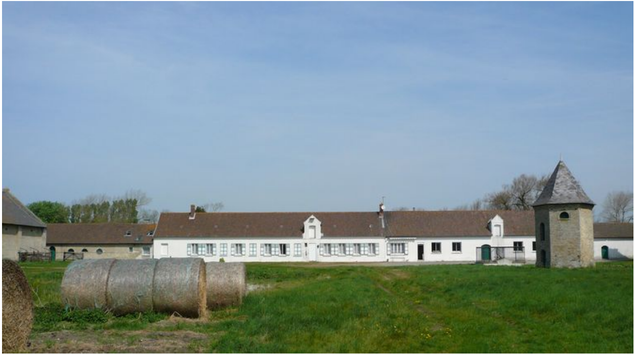
Vue des bâtiments situés au nord : les écuries, le logis et les étables à cochons.
