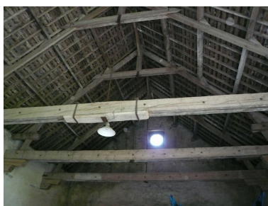
Vue d'une partie de la charpente de la grange. Phot. Inès Guérin IVR22_20078005902NUCA
