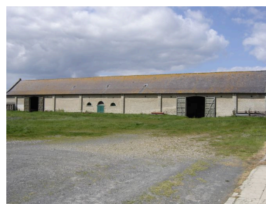
Vue des bâtiments situés à l'ouest : grange et étables. Phot. Catherine Fourmond IVR22_20058001508NUCA
