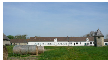
Vue des bâtiments situés au nord : les écuries, le logis et les étables à cochons. Phot. Inès Guérin IVR22_20048001090NUCA
