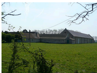
Vue postérieure de la grange et des étables à l'ouest. Phot. Inès Guérin IVR22_20078005662NUCA
