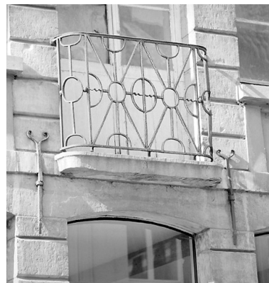
Façade, étage, travée centrale, détail : balcon. Phot. Pierre Thibaut IVR31_20055900840X
