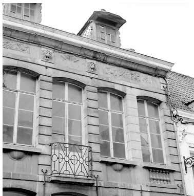
Façade, étage, vue partielle. Phot. Pierre Thibaut IVR31_20055900842X
