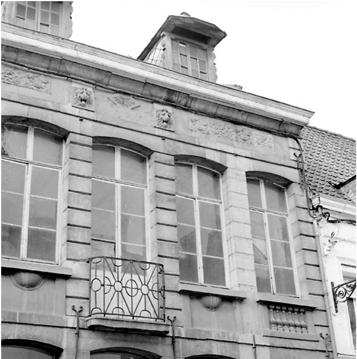
Façade, étage, vue partielle.
