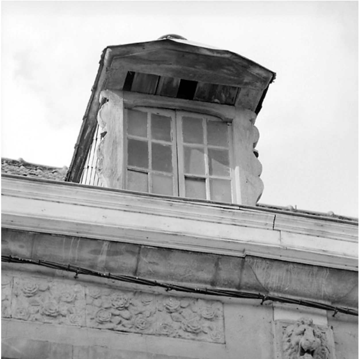
Façade, détail : lucarne.
