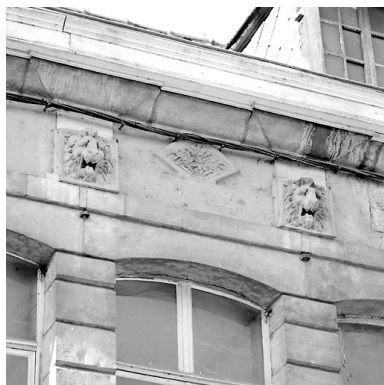
Façade, niveau supérieur, détail : décor appliqué sur l'allège. Phot. Pierre Thibaut IVR31_20055900839X
