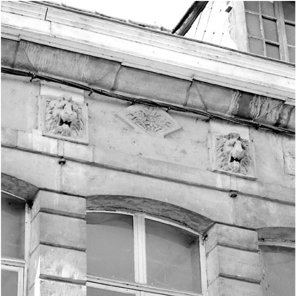
Façade, niveau supérieur, détail : décor appliqué sur l'allège.
