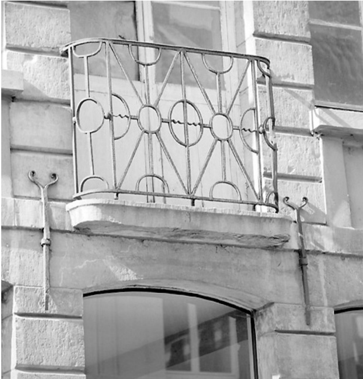
Façade, étage, travée centrale, détail : balcon.
