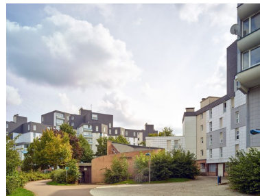
Élévation principale nord ouest. Phot. Pierre Thibaut IVR31_20155901637NUCA
