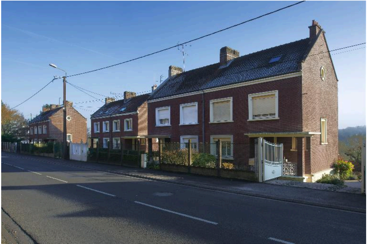
Vue des façades sur rue des logements.
