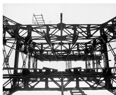
Portique assemblage : détail. Phot. Caudroit Philippe IVR31_19816202765X
