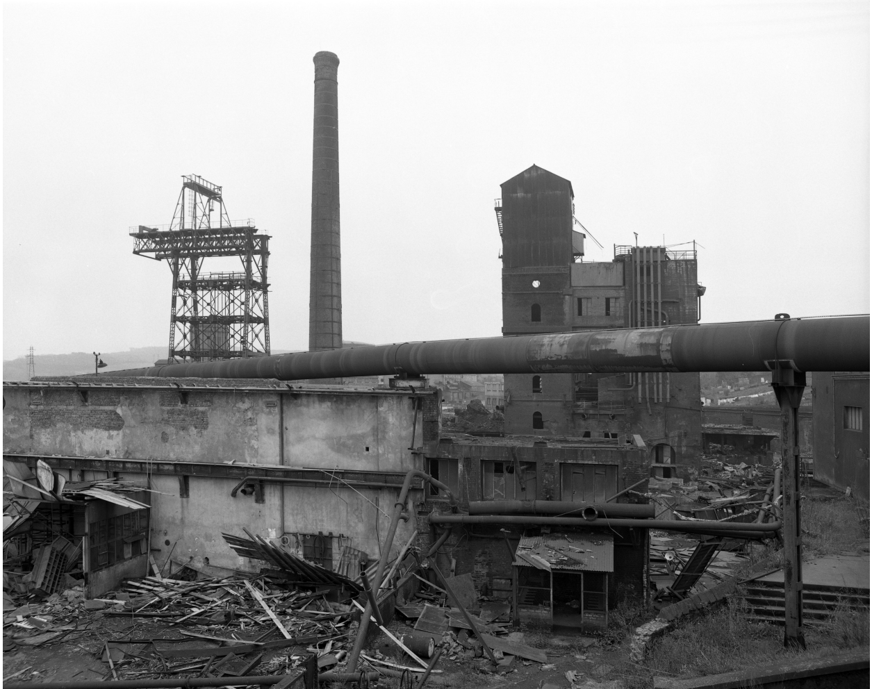
Vue d'ensemble (élévateur façade nord, cheminée d'usine, portique).
