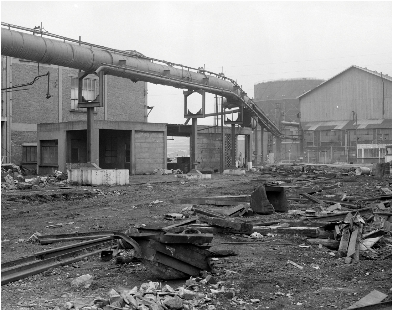
Vue d'ensemble (turbos, redresseur, réfectoire, conduite, salle de coulée).
