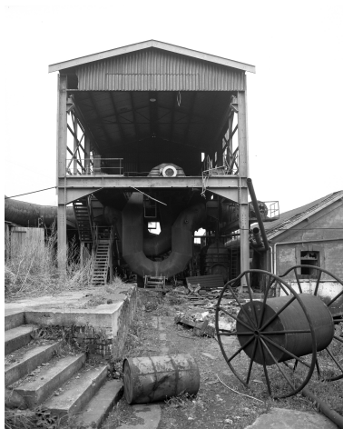
Station de surpression : pignon. Phot. Philippe Caudroit IVR31_19816202852X
