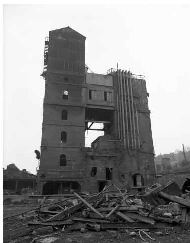
Elévateur, façade nord. Phot. Caudroit Philippe IVR31_19816202732X
