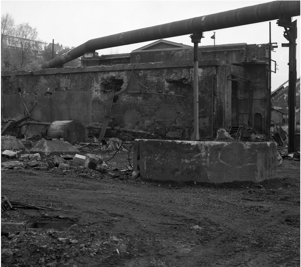
Compresseur, redresseur : façade sud.
