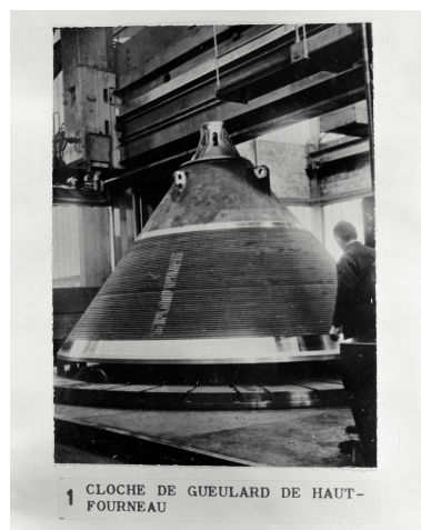
1 CLOCHE DE GUEULARD DE HAUT-FOURNEAU Production (gueulard de haut fourneau) (cliché collection privée). Phot. Caudroit Philippe IVR31_19816202827X
