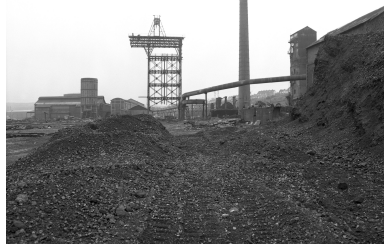
Vue d'ensemble (magasin général, réfrigérant, portique, cheminée d'usine, élévateur). Phot. Philippe Caudroit IVR31_19816202847X
