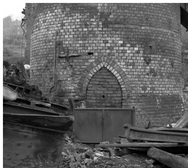
Cheminée d'usine, partie basse : détail. Phot. Caudroit Philippe IVR31_19816202739X
