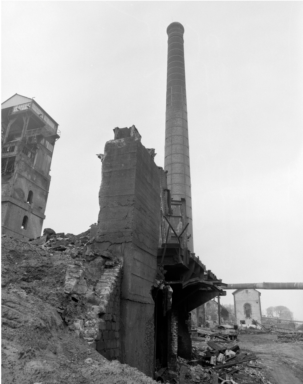
Vue d'ensemble (élévateur, cheminée d'usine, outillage).
