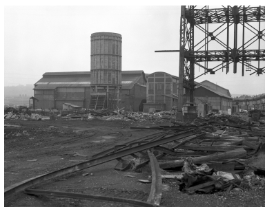
Vue d'ensemble (magasin général, réfrigérant, turbos, redresseurs). Phot. Caudroit Philippe IVR31_19816202734X
