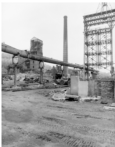
Vue d'ensemble (élévateur façade sud, conduites, portiques). Phot. Caudroit Philippe IVR31_19816202812X
