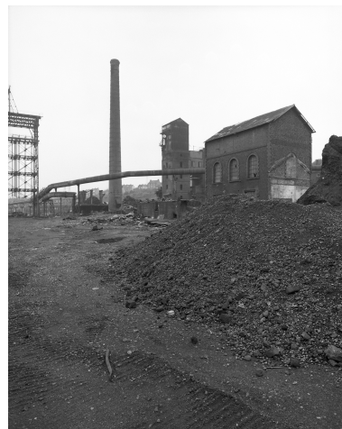
Vue d'ensemble nord (chaudronnerie, portique, élévateur, cheminée d'usine). Phot. Philippe Caudroit IVR31_19816202846X
