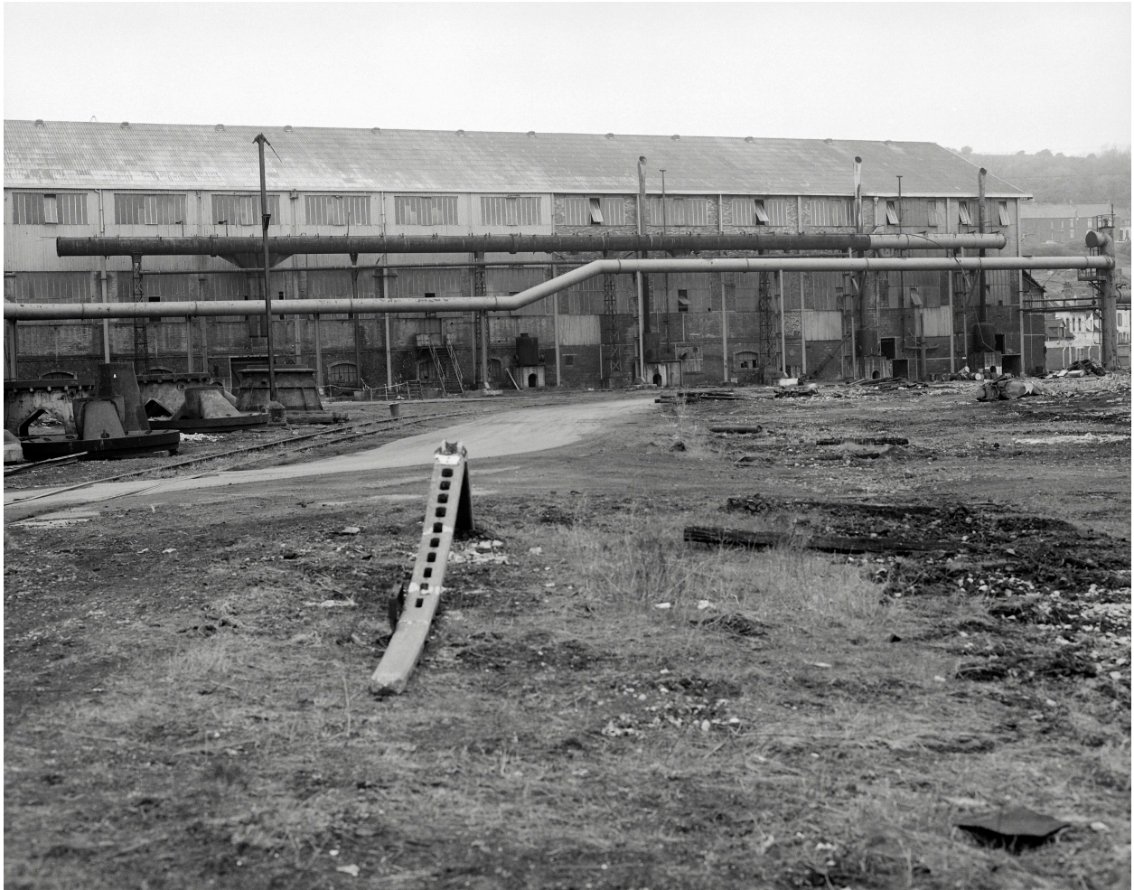
Centrale à gaz : façade sur cour.
