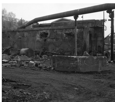
Compresseur, redresseur : façade sud. Phot. Caudroit Philippe IVR31_19816202738X
