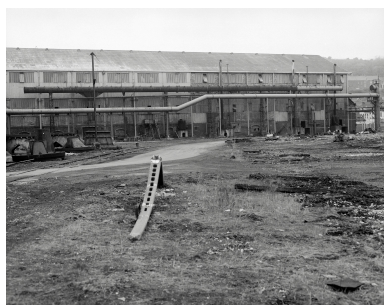
Centrale à gaz : façade sur cour. Phot. Caudroit Philippe IVR31_19816202763X
