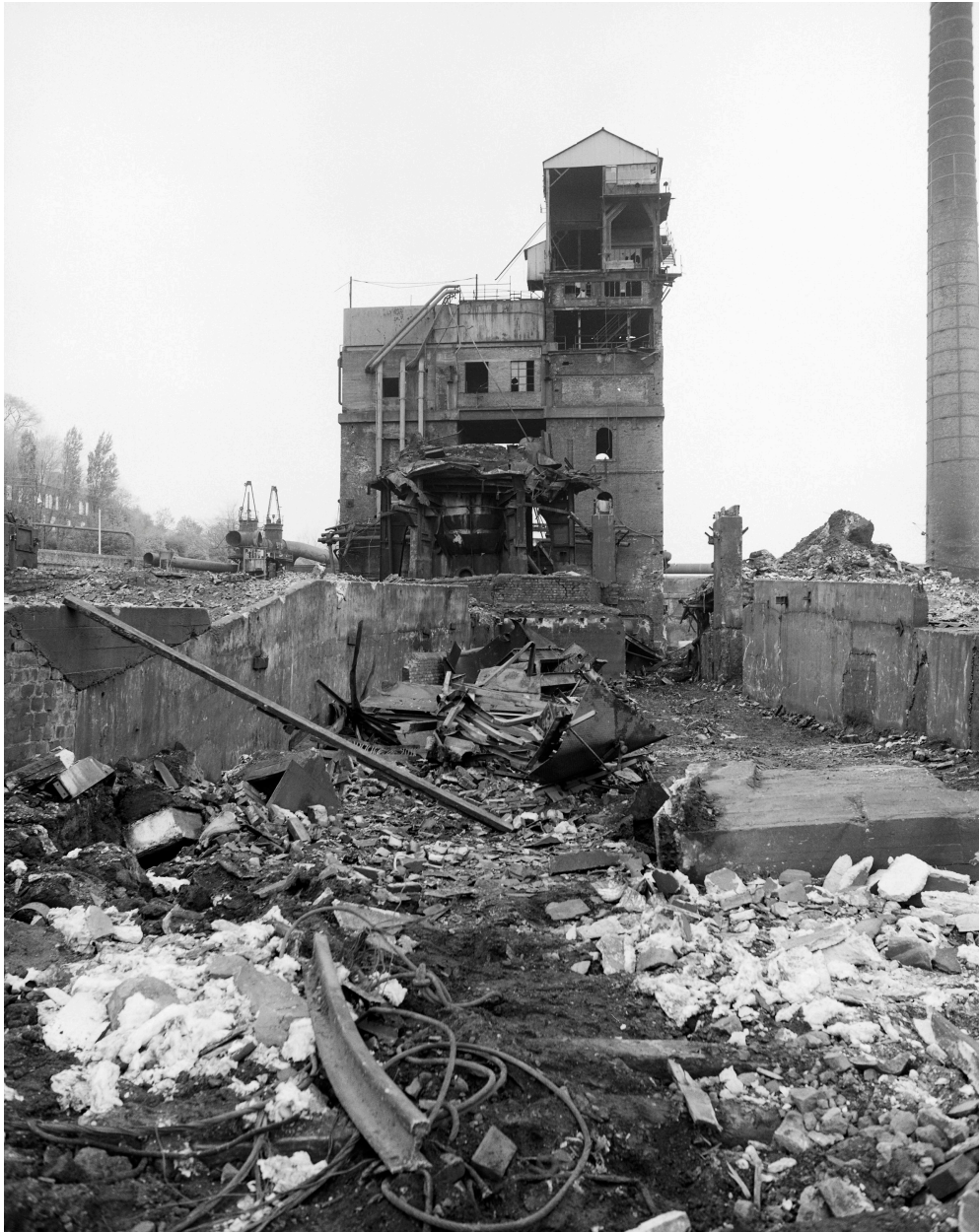
Elévateur, façade sud.
