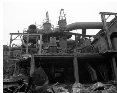
Brûleur : façade sur cour. Phot. Caudroit Philippe IVR31_19816202731X
