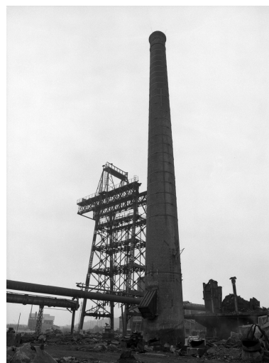
Cheminée d'usine, vue générale. Phot. Caudroit Philippe
