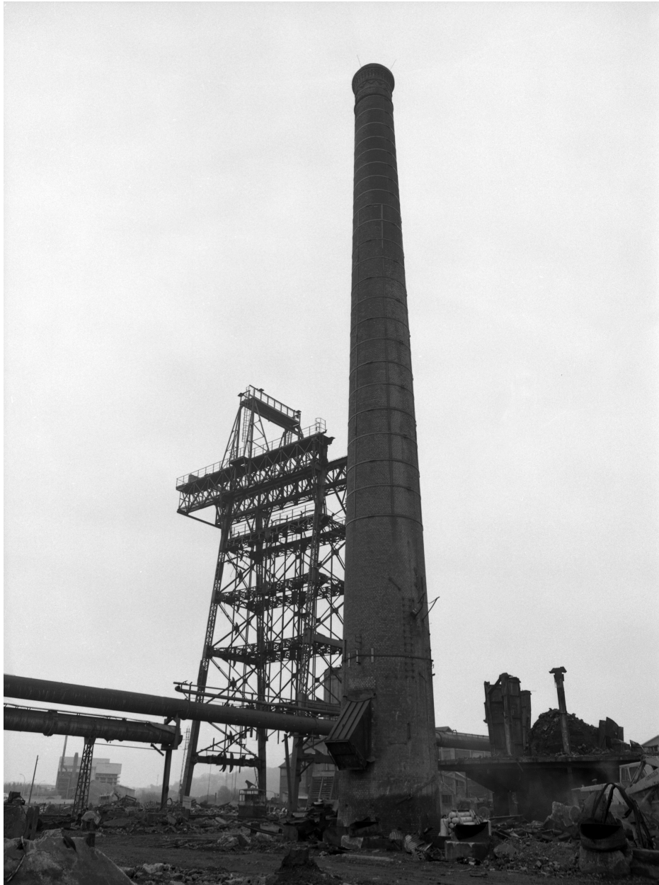
Cheminée d'usine, vue générale.
