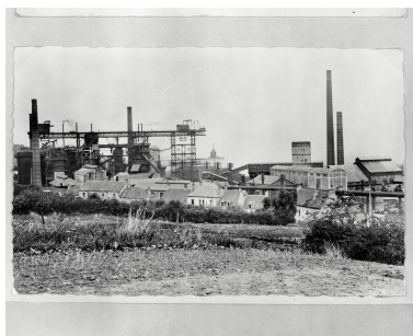
Vue générale vers le nord avant destruction (cliché collection privée). Phot. Jean-Michel Périn IVR31_19816202826XB
