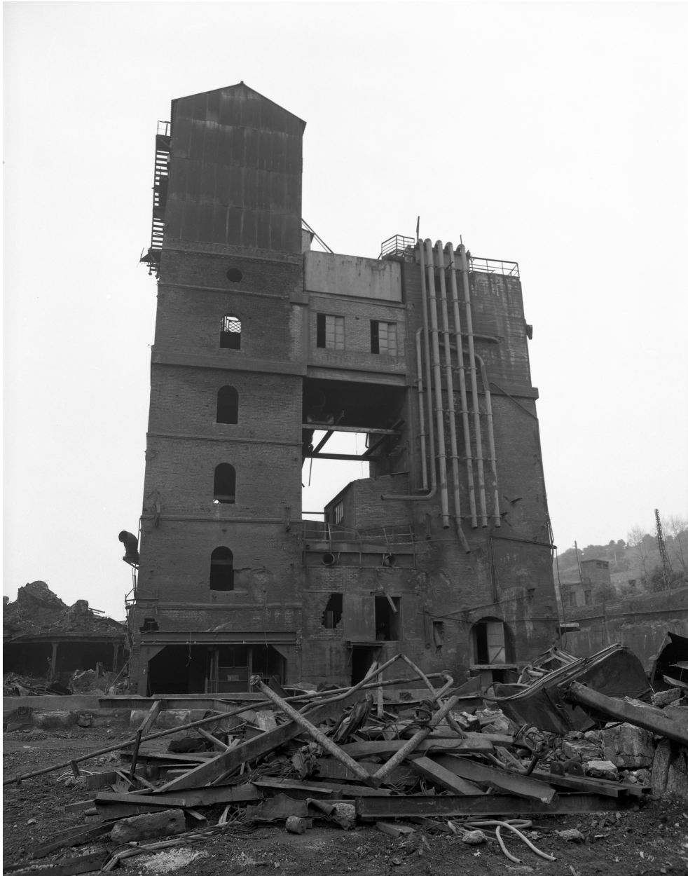
Elévateur, façade nord.
