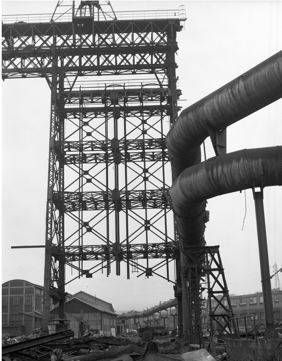
Portique : vue générale.
