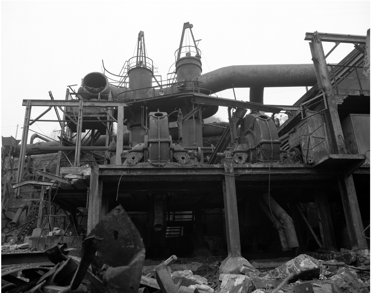
Brûleur : façade sur cour.
