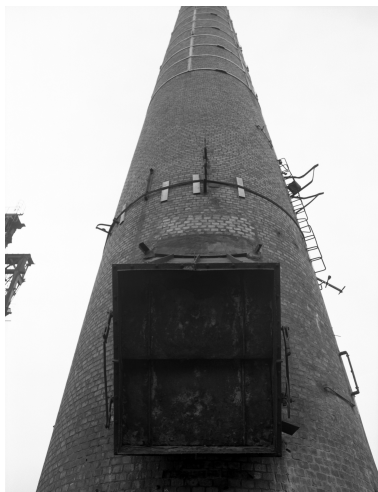
Cheminée d'usine, partie médiane : détail. Phot. Caudroit Philippe IVR31_19816202733X
