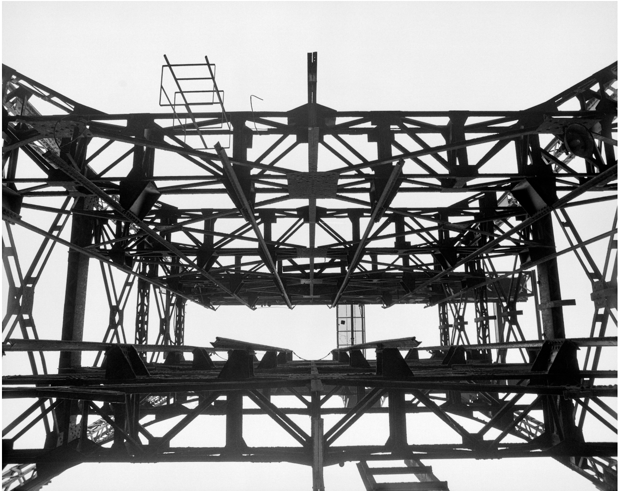
Portique assemblage : détail.
