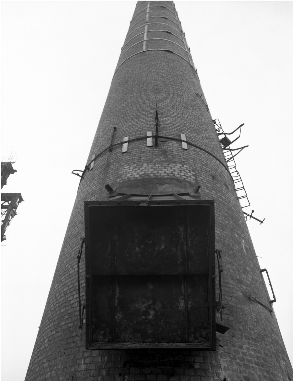
Cheminée d'usine, partie médiane : détail.
