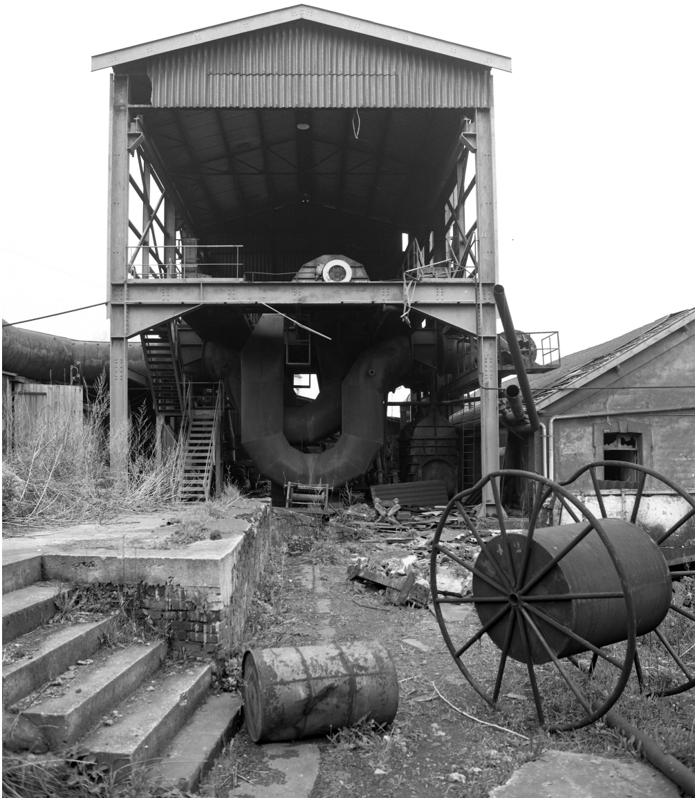
Station de surpression : pignon.
