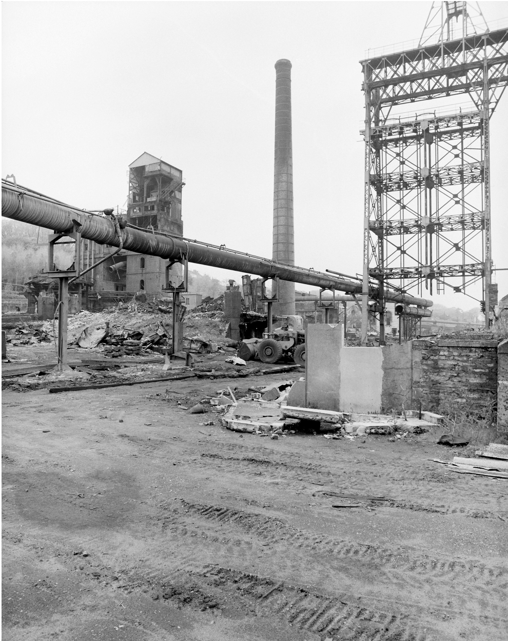
Vue d'ensemble (élévateur façade sud, conduites, portiques).
