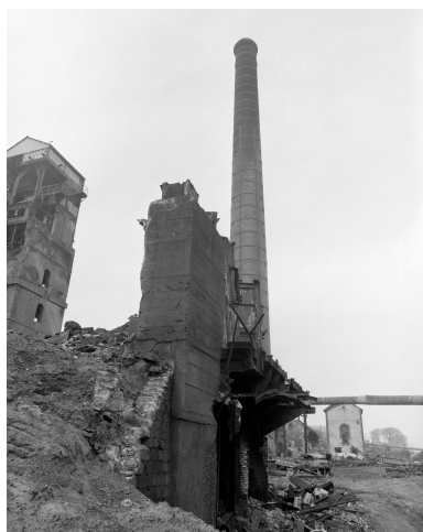
Vue d'ensemble (élévateur, cheminée d'usine, outillage). Phot. Caudroit Philippe
