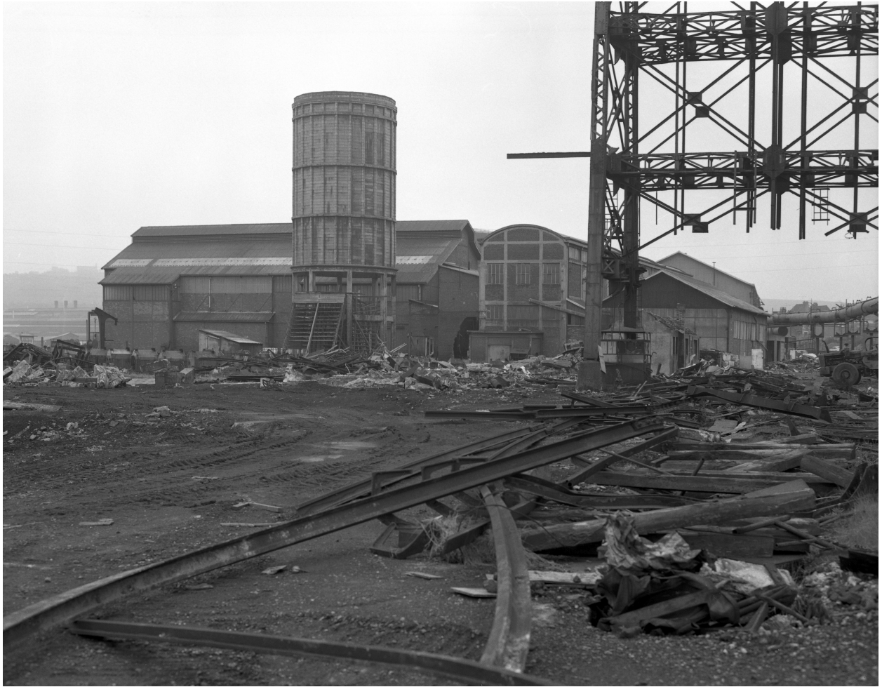
Vue d'ensemble (magasin général, réfrigérant, turbos, redresseurs).
