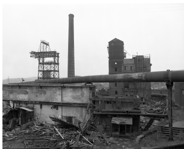
Vue d'ensemble (élévateur façade nord, cheminée d'usine, portique). Phot. Philippe Caudroit IVR31_19816202845X
