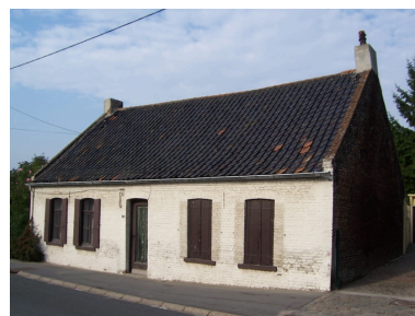
Vue sur la rue du Maréchal-Leclerc. Phot. Cyril Cailleau IVR31_20055907442NUCA
