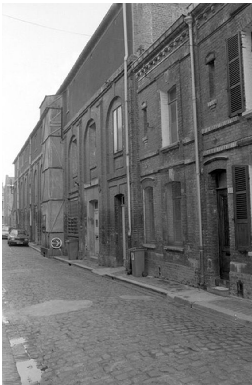
Atelier de la rue Guérard, façade nord.
