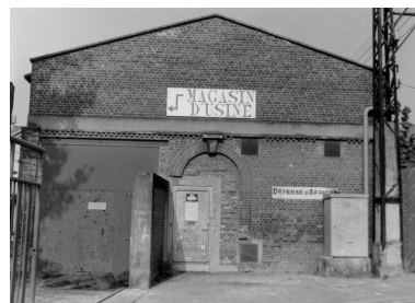
Ancienne chaufferie. Phot. Benoît Dufournier IVR22_19888000530Z
