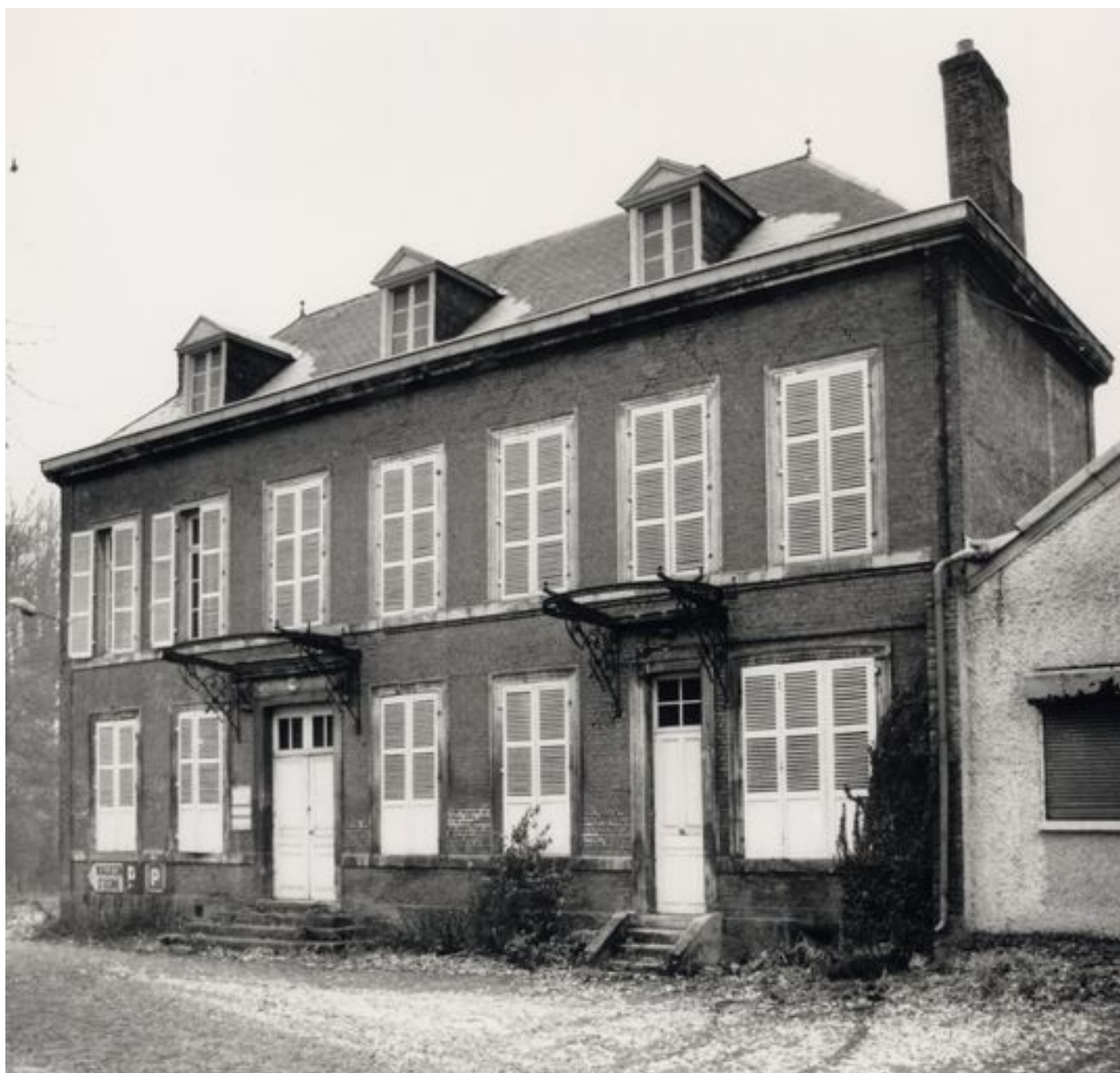
Logement patronal et bureaux.
