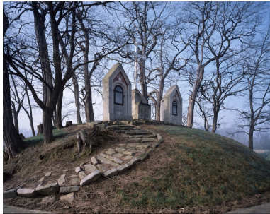
Vue générale du chemin calvaire et son chemin d'accès. Phot. Pierre Thibaut IVR31_20095901343VA
