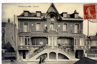
Cayeux. L'ancien Kursaal (détruit). Phot. Monnehay-Vulliet Marie-Laure IVR22_20058000459XAB
