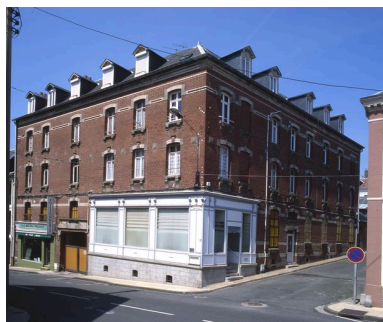
Ancien Hôtel de France au Bourg d'Ault. Phot. Marie-Laure Monnehay-Vulliet IVR22_20058001167XA
