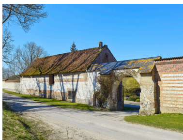
Entrée de la ferme et grange depuis le nord-est. Phot. Thierry Lefébure IVR32_20258000285NUCA
