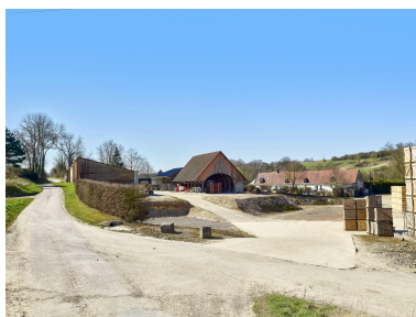
Vue d'ensemble de la ferme, depuis le nord. Phot. Thierry Lefébure IVR32_20258000287NUCA
