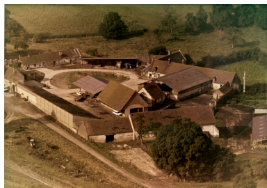
Vue aérienne de la ferme, deuxième moitié du XXe siècle (coll. part). Repro. Thierry Lefébure IVR32_20258000220NUCA
