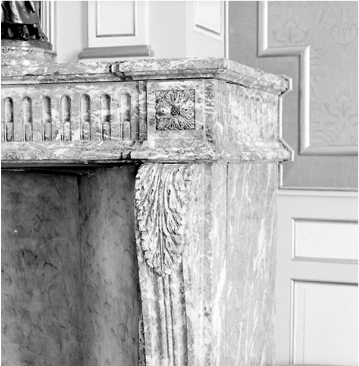
Détail : angle droit (piédroit, linteau de façade, linteau de jouée).
