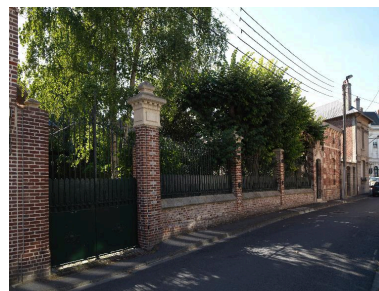
Portail et mur de clôture, rue Vadé. Phot. Marie-Laure Monnehay-Vulliet IVR22_20158000876NUC2A
