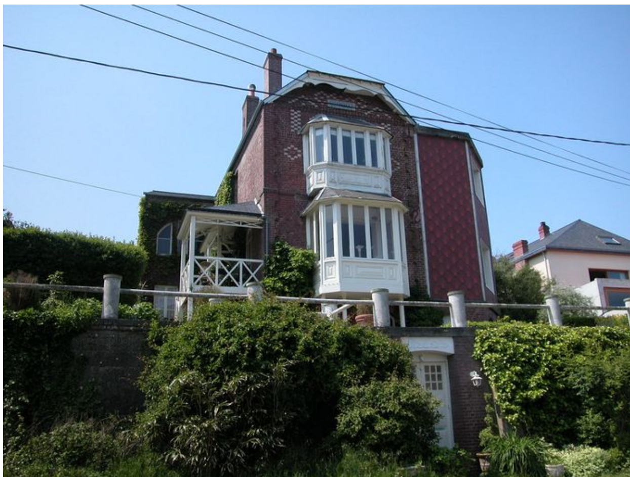
Vue d'ensemble, élévation côté mer.
