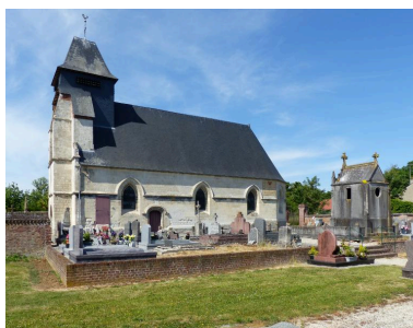
Vue depuis le sud. Phot. Isabelle Barbedor IVR32_20208005273NUCA
