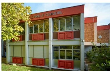
La façade du bâtiment situé immédiatement à gauche de l'entrée (depuis le parvis).
