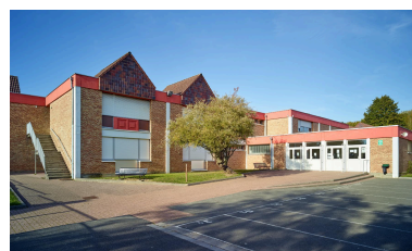
Vue depuis la cour, au sud. Phot. Pierre Thibaut IVR32_20185901171NUCA
