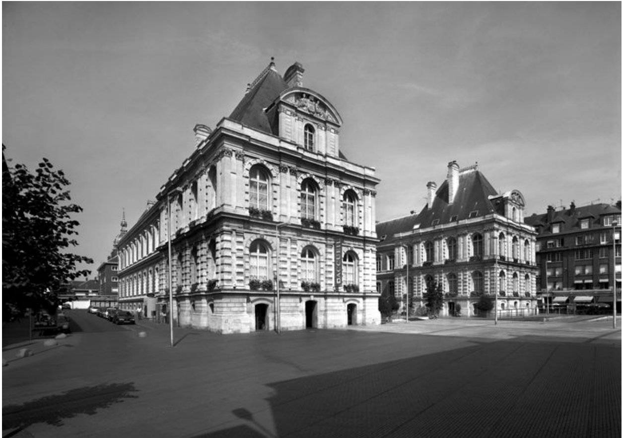
Vue générale, depuis le sud-ouest.
