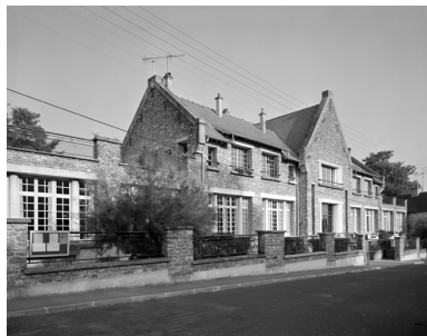
Vue générale depuis la rue. Phot. Thierry Lefébure IVR22_19940201185V
