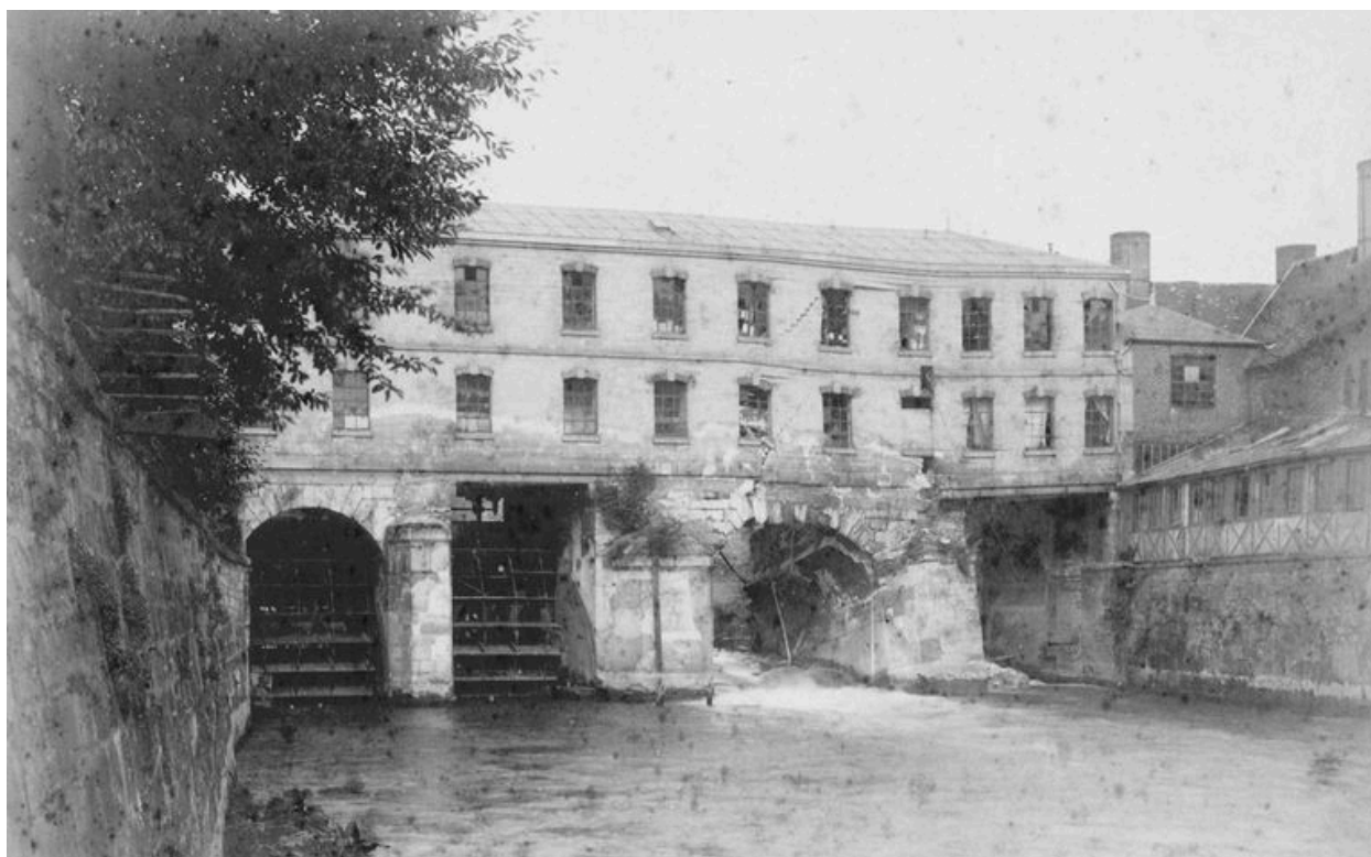
Vue du bâtiment construit sur le petit bras de l'Oise en aval. On distingue à droite les deux roues hydrauliques verticales sous les arches du pont (musée Gallé-Juillet, Creil).
