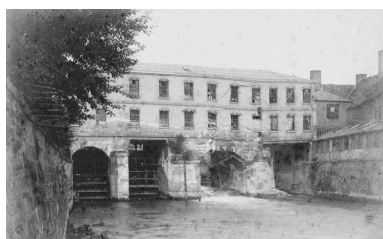
Vue du bâtiment construit sur le petit bras de l'Oise en aval. On distingue à droite les deux roues hydrauliques verticales sous les arches du pont (musée Gallé-Juillet, Creil). Repro. Clarisse Lorieux IVR22_20076005437NUCAB
