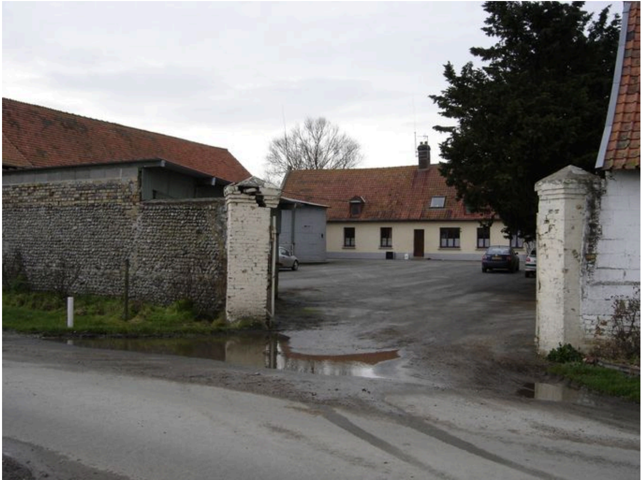
Vue de l'entrée de la ferme depuis la rue.
