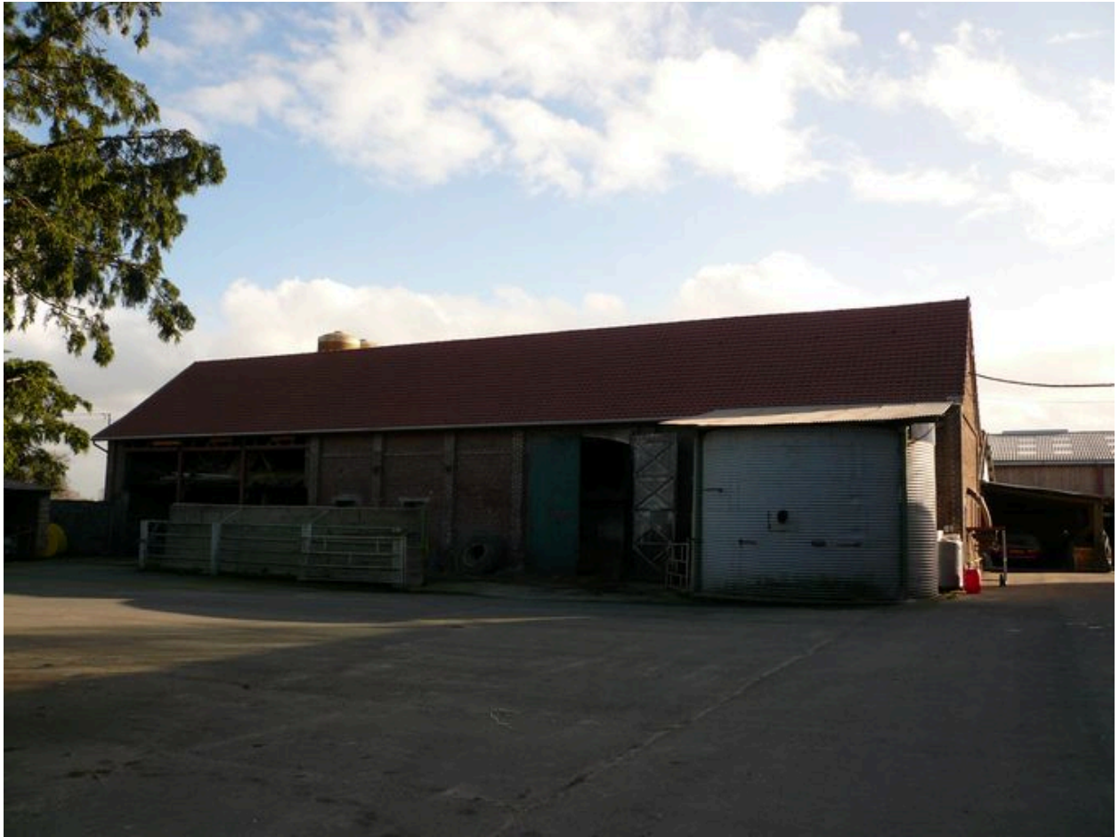
Vue de la grange au sud.
