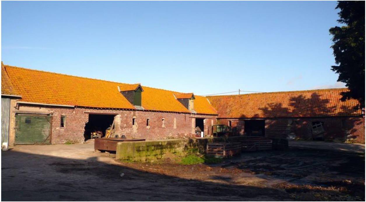
Vue des étables au nord-est de la cour.
