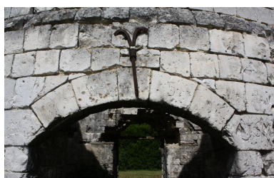
Flixecourt, moulin Basile : détail du linteau de la porte. Phot. Bertrand Fournier IVR22_20098005100NUCA
