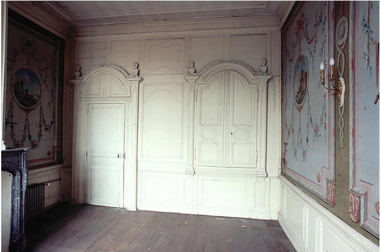
Vue générale de la salle des bateliers : à gauche, panneau de toile peinte du mur sud-ouest, à droite, panneau du mur nord-est.
