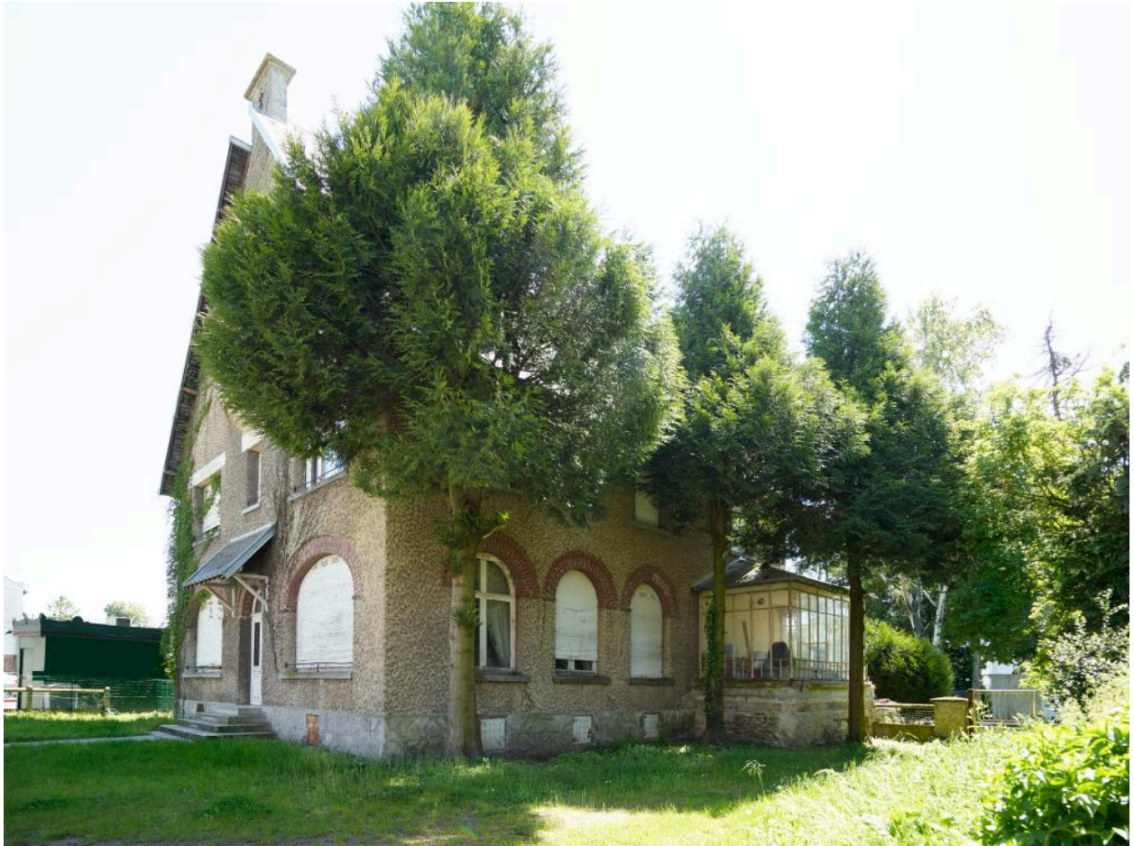
Façade latérale droite.
