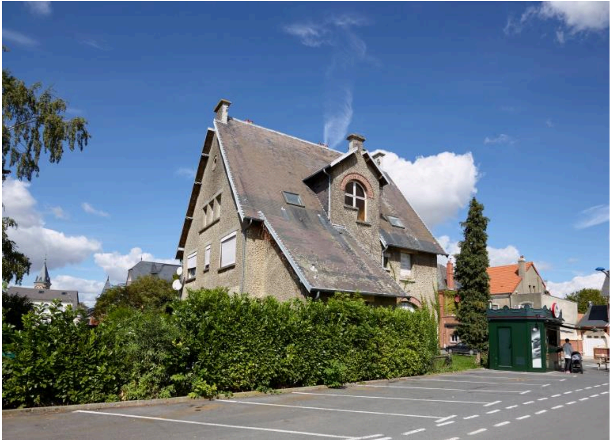
Façade latérale gauche depuis l'ancienne cour de la ferme (actuel parking de supermarché).
