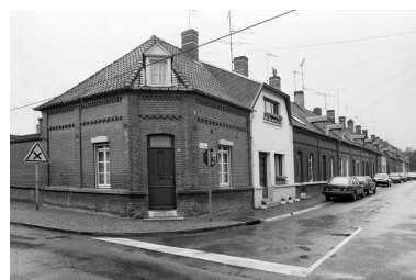
Vue de la rive sud de la cité Saint-Guillaume, en 1991. Phot. Benoît Dufournier IVR22_19918000260Z
