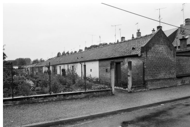
Vue des dépendances et des jardins, à l'arrière des logements, en 1991.
