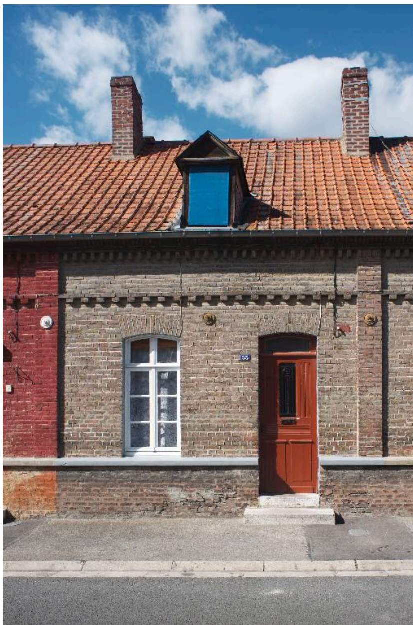
Façade sur rue du logement sis au 33 rue Léon-Hénocque.
