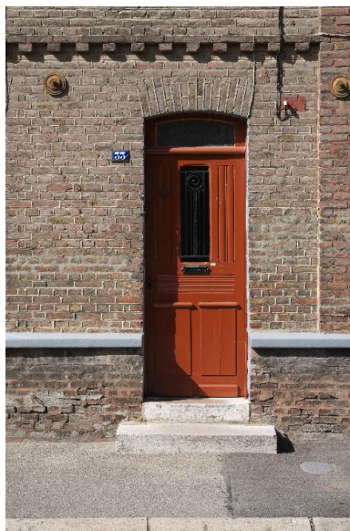
Détail de la porte d'entrée sur rue, 33 rue Léon-Hénocque.
