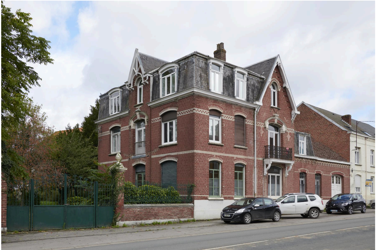
Façade sur rue et façade sur jardin.
