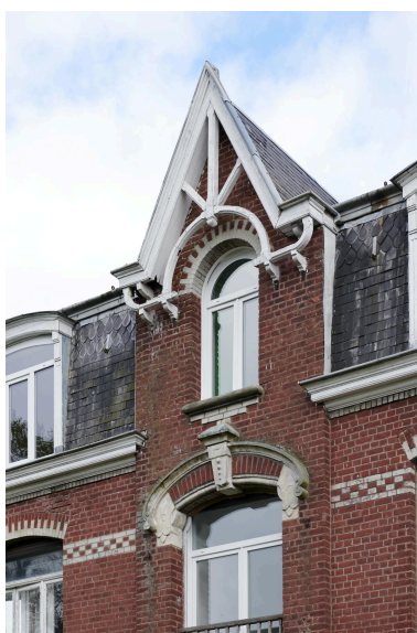
Détail de la partie supérieure de la travée centrale. Phot. Delphine Volto Jourdan IVR32_20245903232NUCA
