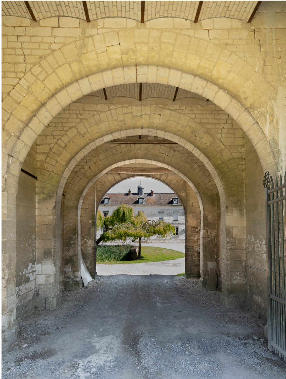
Entrée côté sud de la cour de ferme avec porche voûté.
