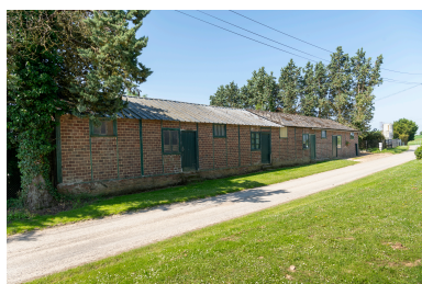
Anciens logements pour les ouvriers saisonniers, vue prise depuis le nord-est. Phot. Marc Kérignard IVR32_20246000505NUCA
