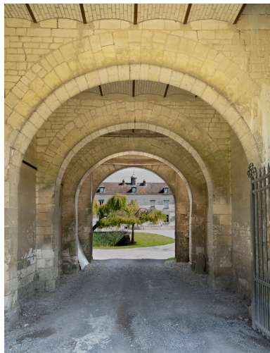
Entrée côté sud de la cour de ferme avec porche voûté. Phot. Marc Kérignard IVR32_20246000502NUCA
