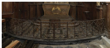
Vue de la partie centrale. Phot. Thierry Lefébure IVR22_20138000621NUC2A
