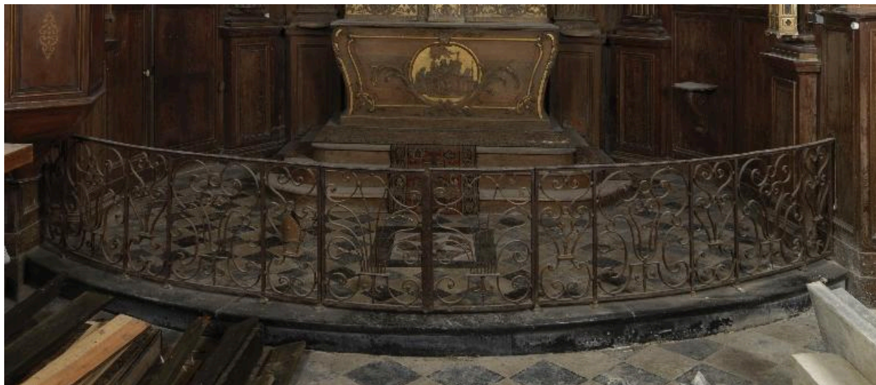
Vue de la partie centrale.
