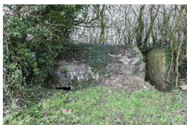
Élévation sud. A gauche l'entrée, au centre, le toboggan permettant d'escamoter la mitrailleuse Phot. Pierre Thibaut IVR31_20155902005NUCA
