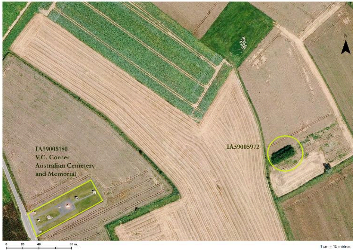
Position de l'édifice (cercle) sur une photographie aérienne de 2004. A gauche l'actuel mémorial austalien de Fromelles
