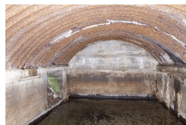
Vue intérieure de l'abri à personnel. A gauche le toboggan à mitrailleuse Phot. Pierre Thibaut IVR31_20155902007NUCA
