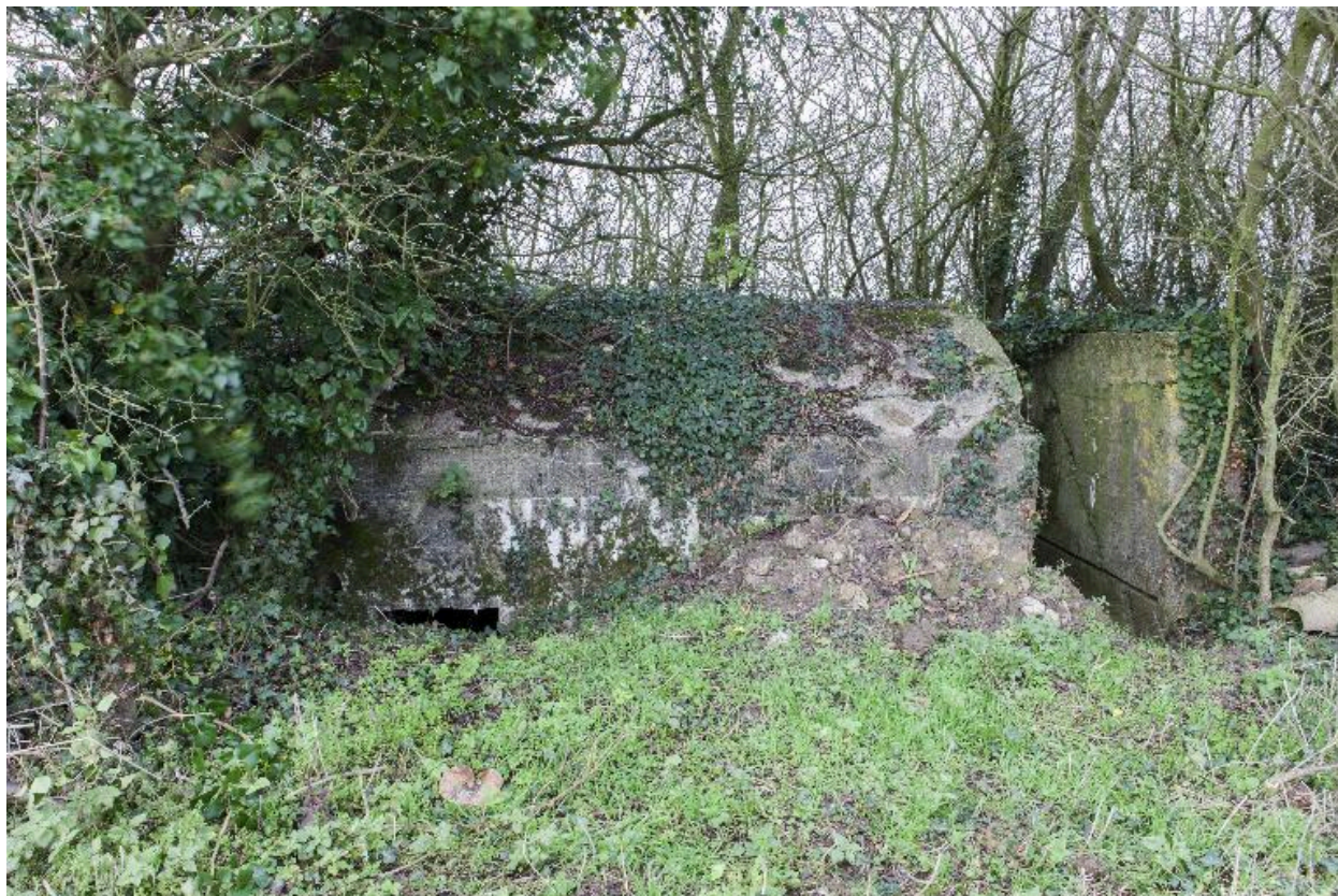
Elévation sud. A gauche l'entrée, au centre, le toboggan permettant d'escamoter la mitrailleuse
