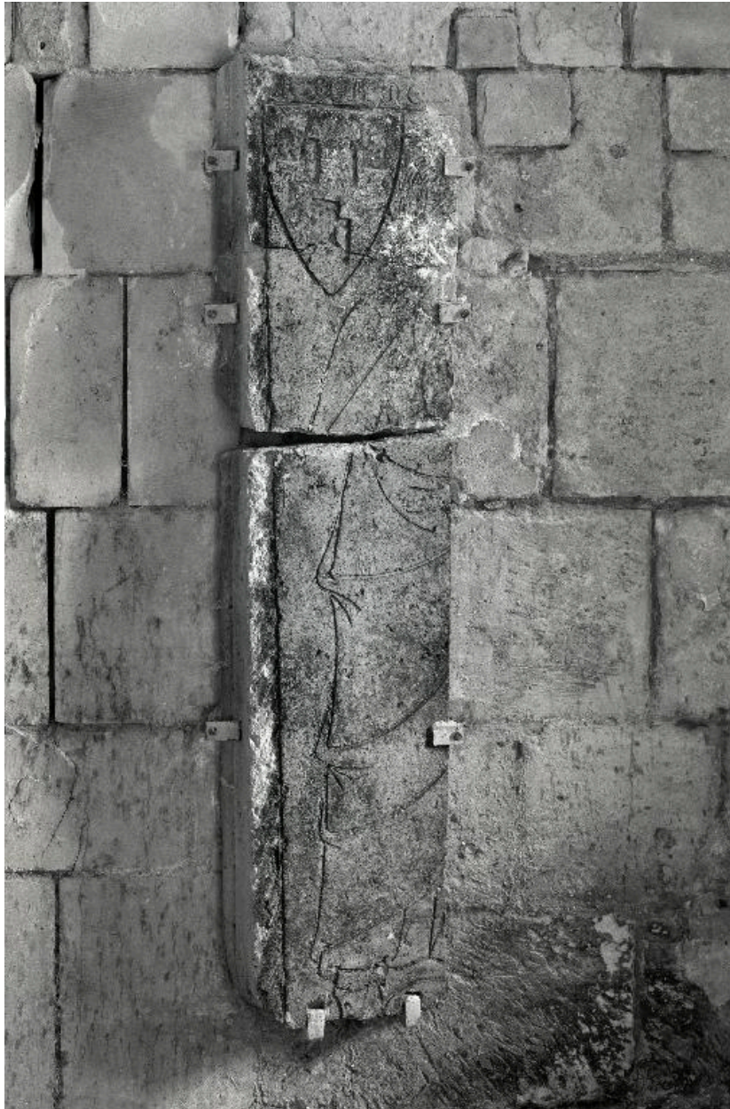
Vue de l'élément subsistant de la dalle.
