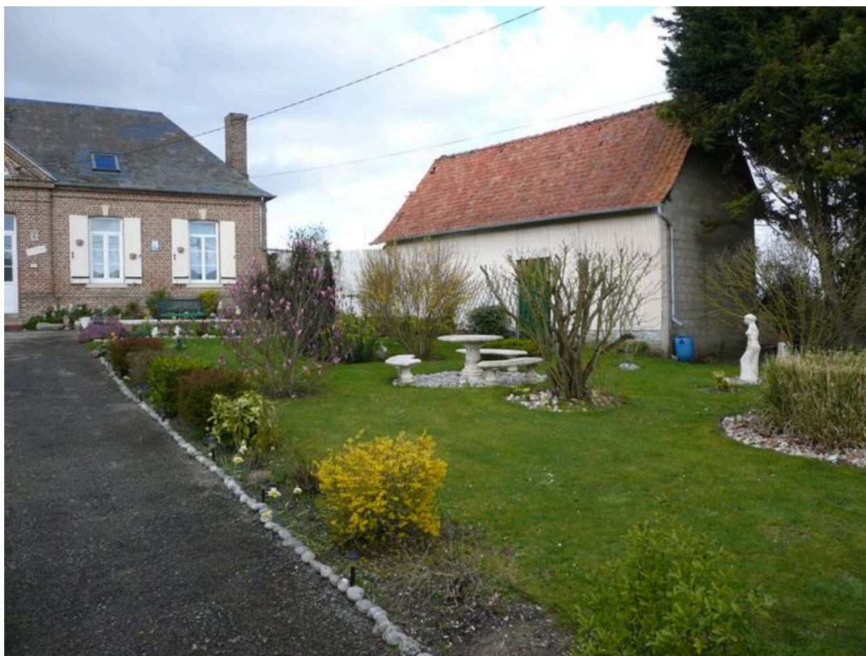
Vue de la grange.
