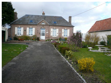
Vue du logis. Phot. Inès Guérin IVR22_20078005629NUCA
