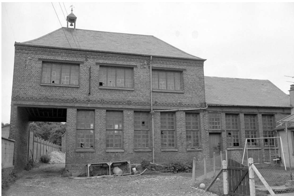
Atelier de fabrication, élévation antérieure, vers 1990.
