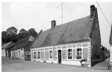
Vue d'ensemble du logis, depuis le sud. Phot. Thierry Lefébure IVR22_19920201076Z
