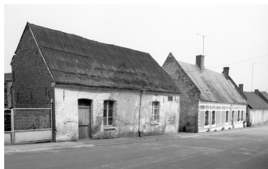
Vue d'ensemble des élévations sur rue. Phot. Thierry Lefébure IVR22_19920201082Z
