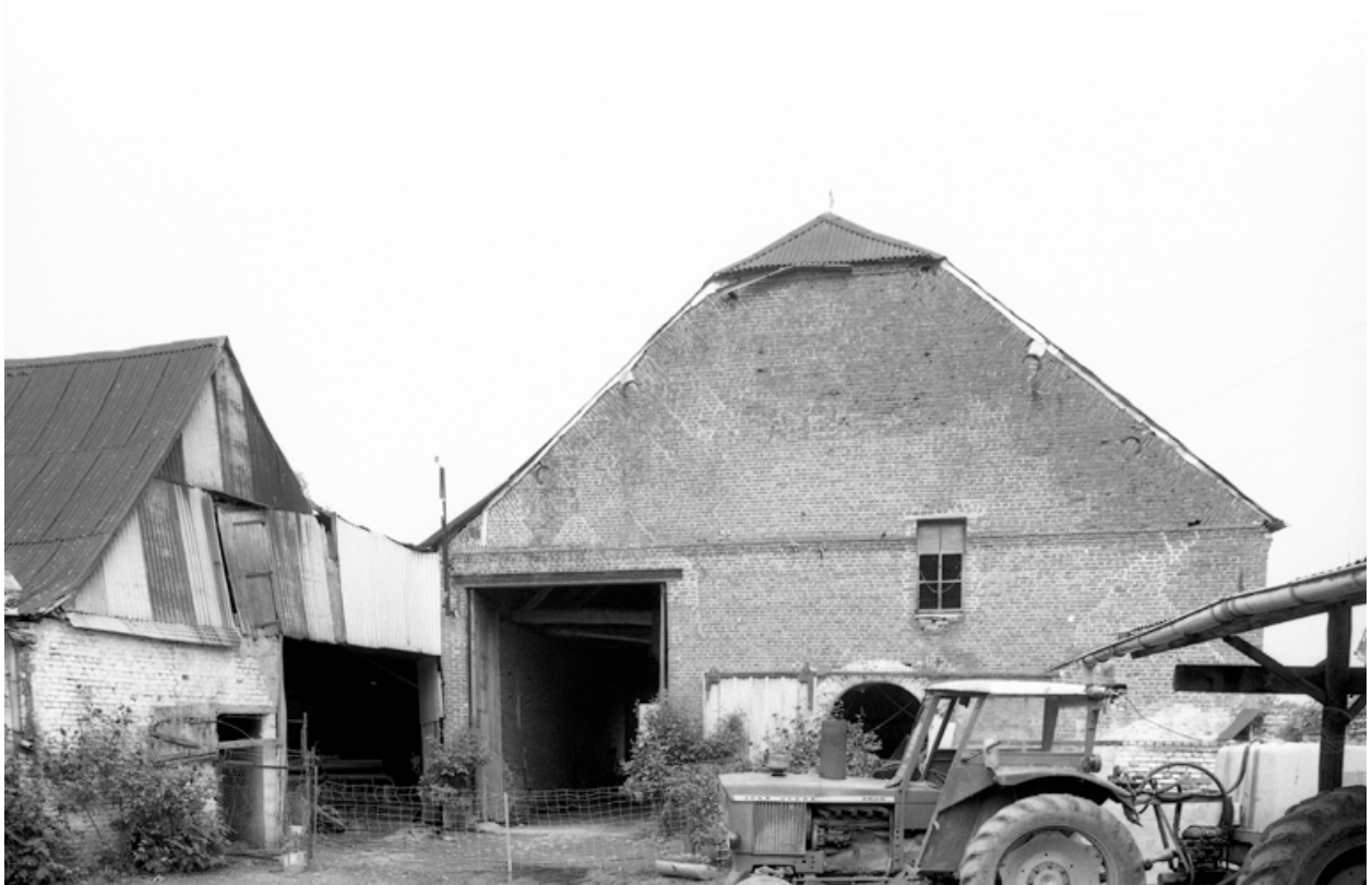
Vue des deux granges, en fond de cour.
