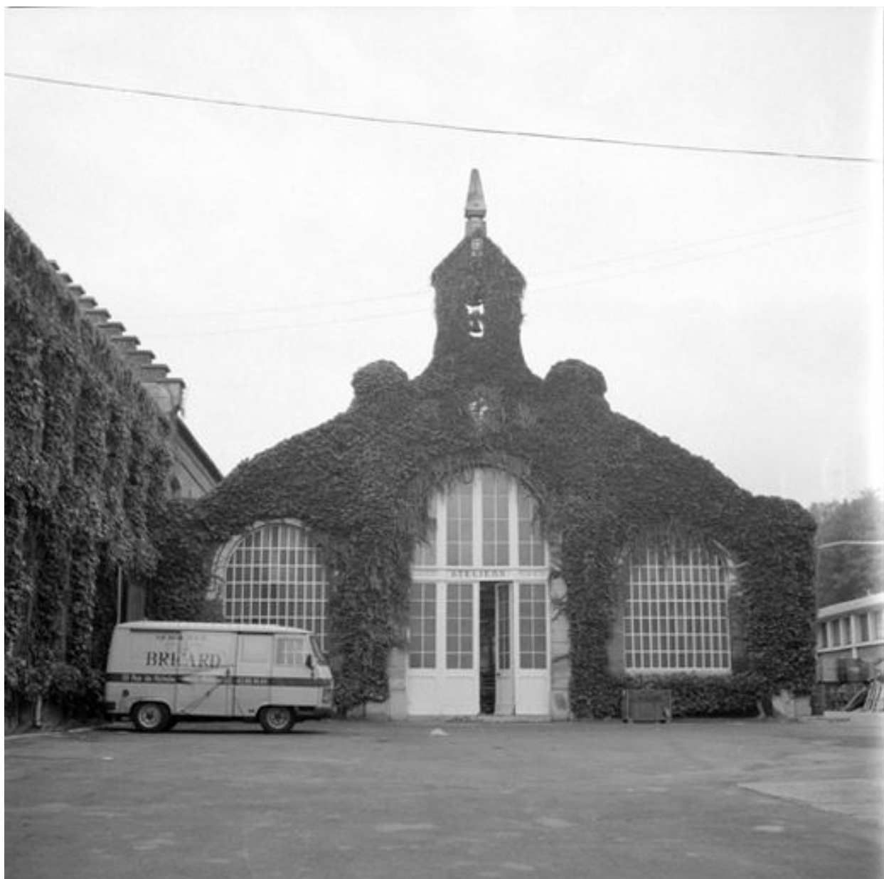
Atelier de fabrication, élévation antérieure, en 1990.
