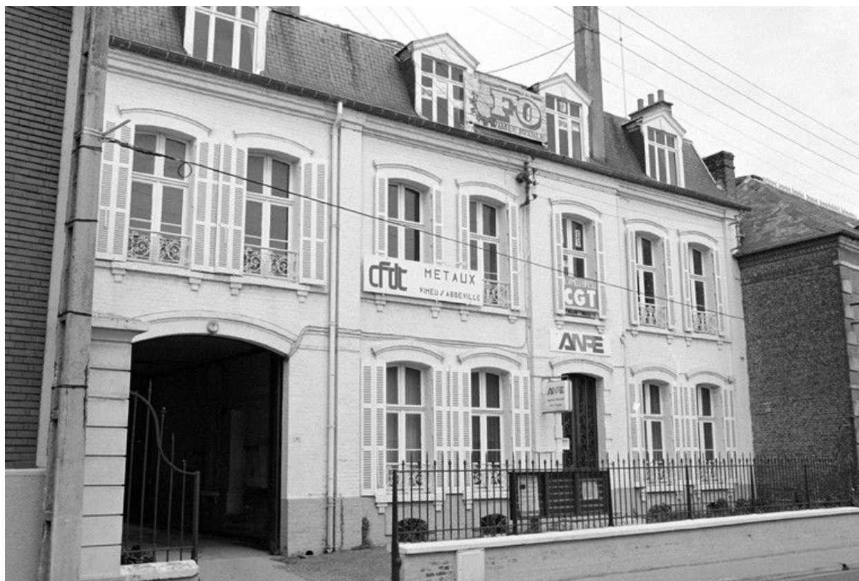
Logement patronal n°1, élévation antérieure, en 1990.
