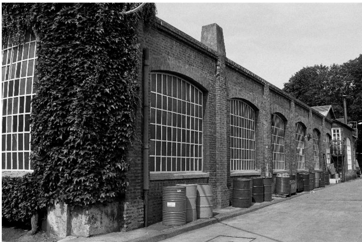
Atelier de fabrication, flanc est, en 1990.
