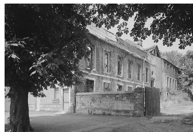
Bâtiment 1 (chapelle), façade sur cour d'honneur. Phot. Jean-Michel Périn, Phot. Éric Dessert IVR31_19806203096X
