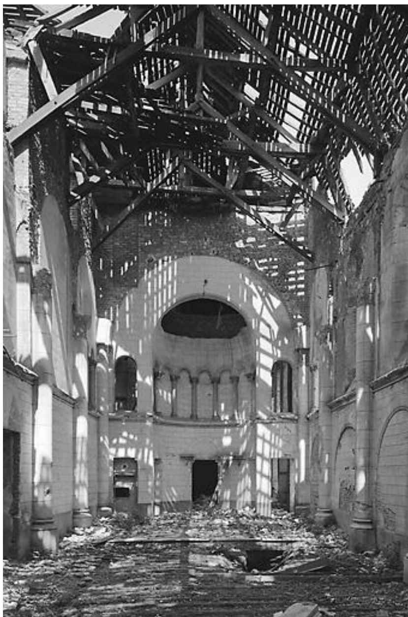
Bâtiment A (chapelle), nef vers chœur.
