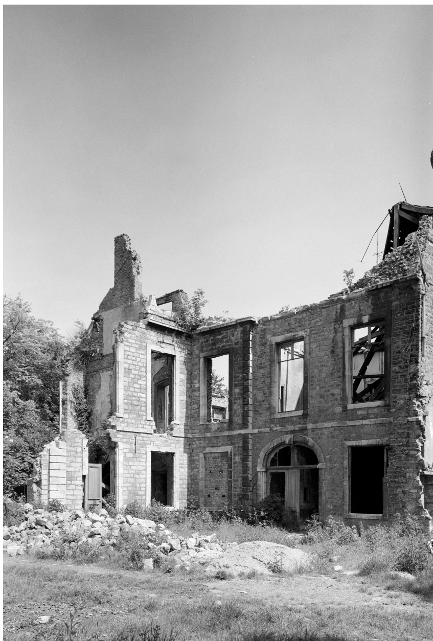
Bâtiments D, G, vue d'angle sur cour d'honneur.
