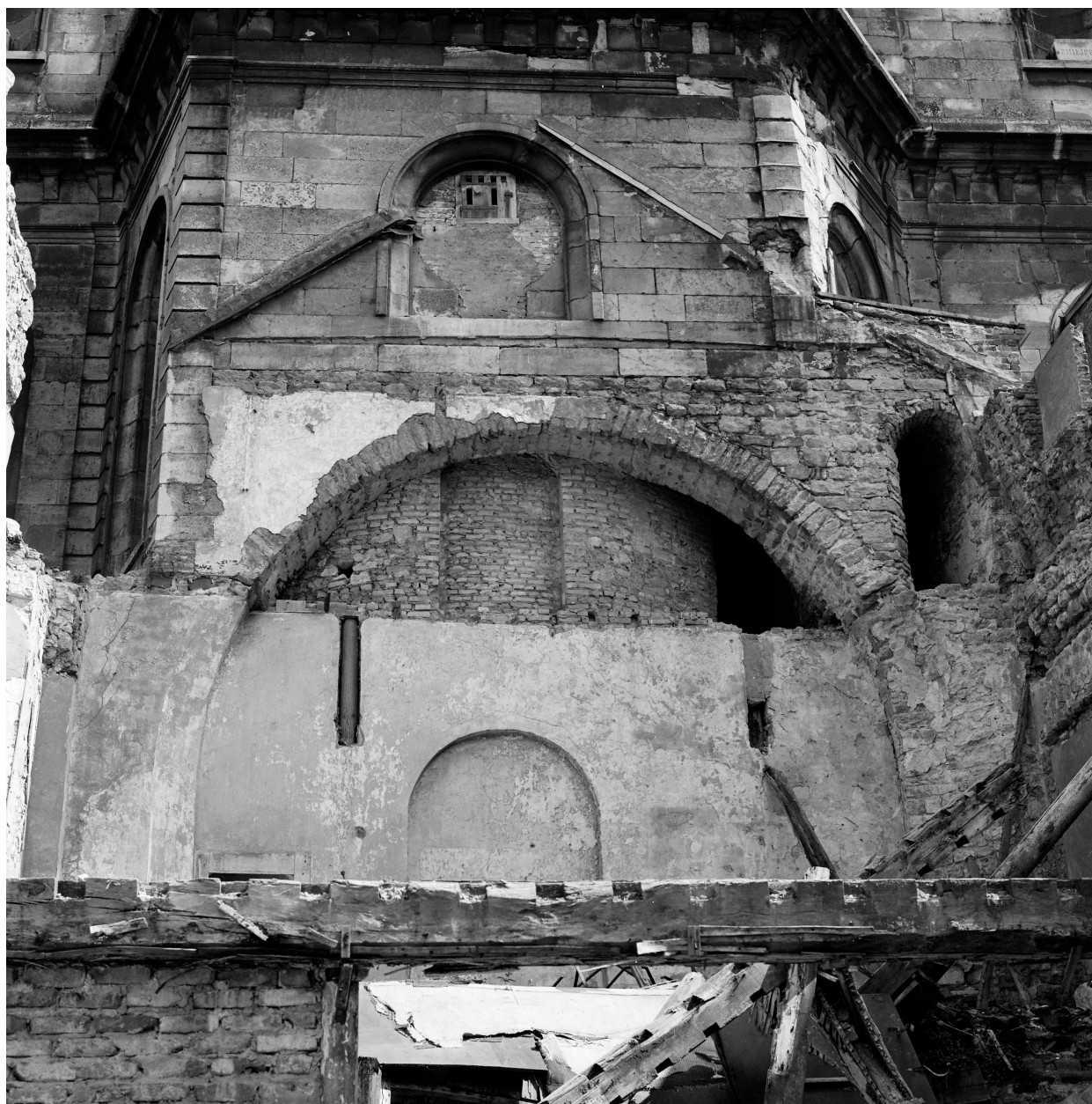
Bâtiment F, vue intérieure, jonction avec église.
