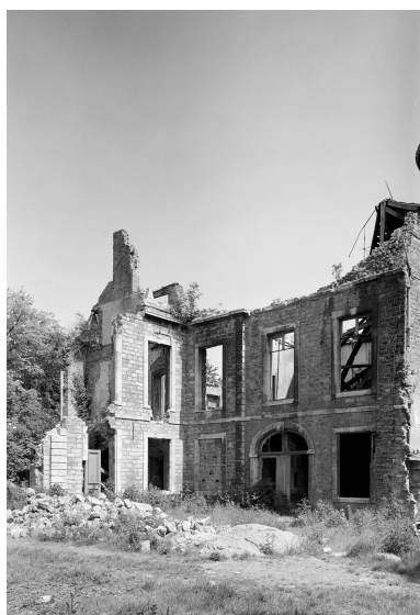
Bâtiments D, G, vue d'angle sur cour d'honneur. Phot. Jean-Michel Périn, Phot. Éric Dessert IVR31_19806203094X
