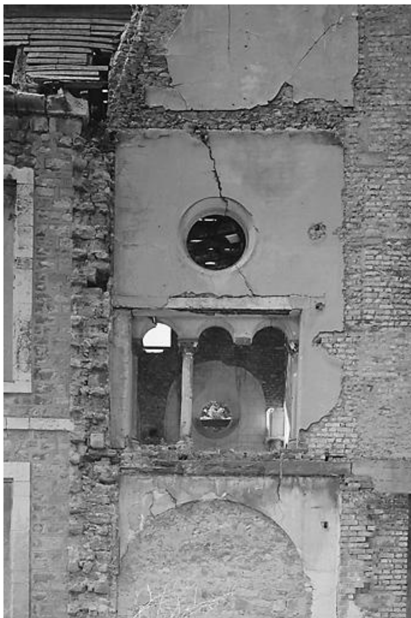
Bâtiment D, vue intérieure vers bâtiment A (ouverture sur chapelle).
